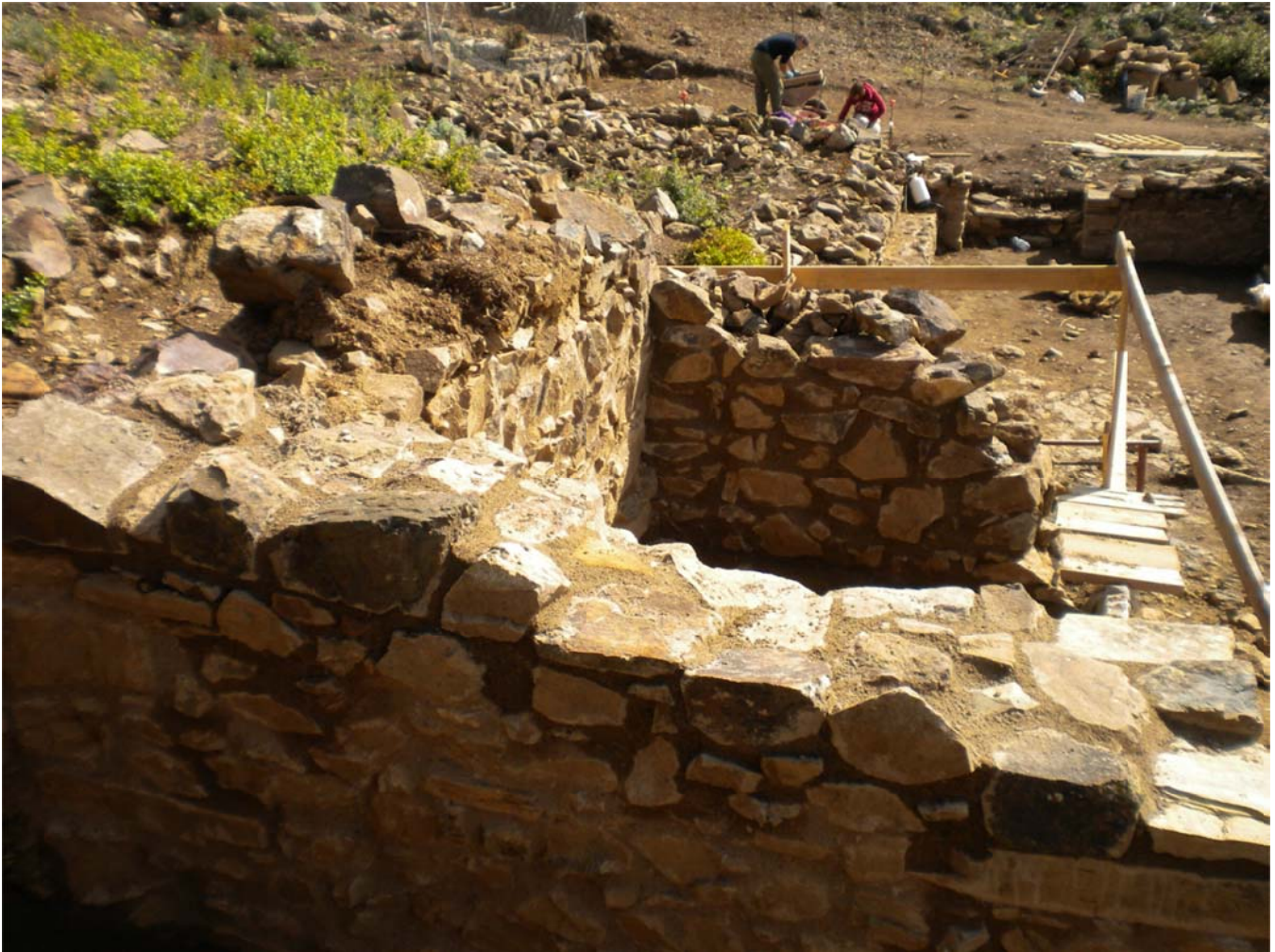
Foto N. 7 - Fasi di restauro e allettamento delle murature emerse
