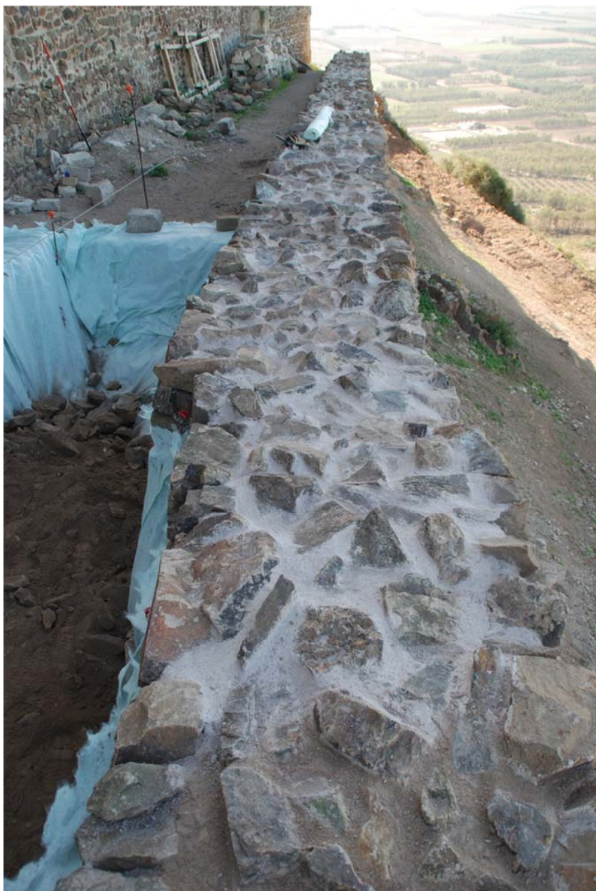
Foto N 12. Protezione delle teste dei muri
