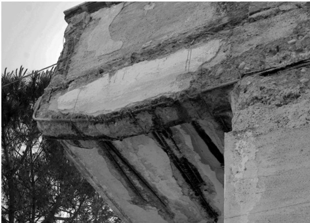
**Sopra: Il calcestruzzo è stato espulso dalle armature**
