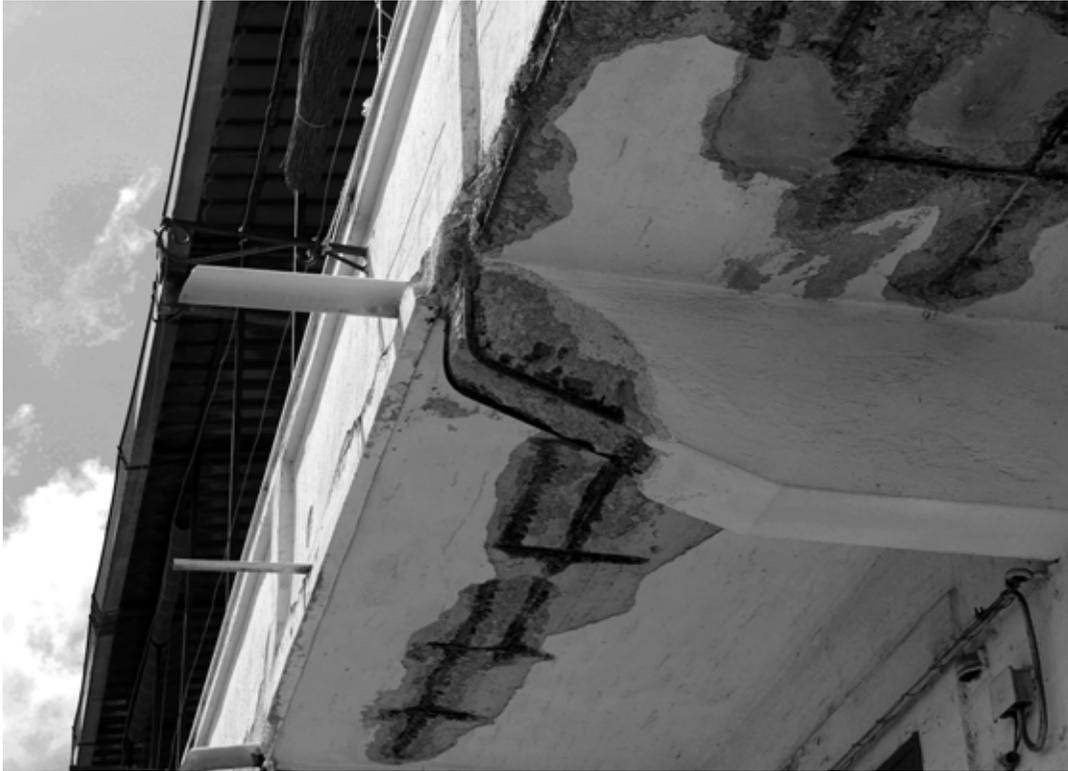
**Sopra: Foto di dettaglio delle armature degradate**
