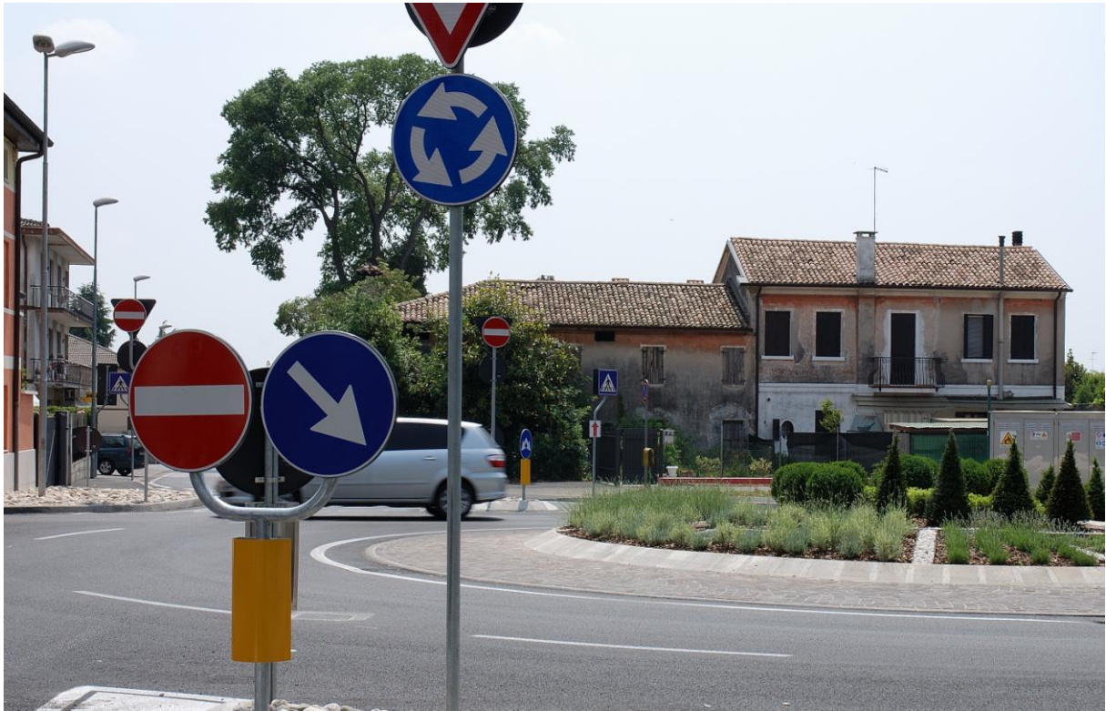
Segnaletica ridondante, inutile, antiestetica e che toglie anche visibilità
