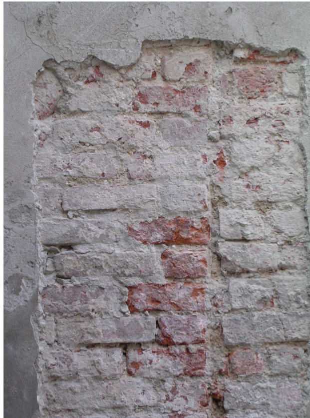
Campioni d'intonaco e della muratura eseguiti sulla facciata laterale,
