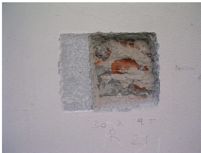
Campioni d'intonaco e della muratura eseguiti sulla facciata laterale,
