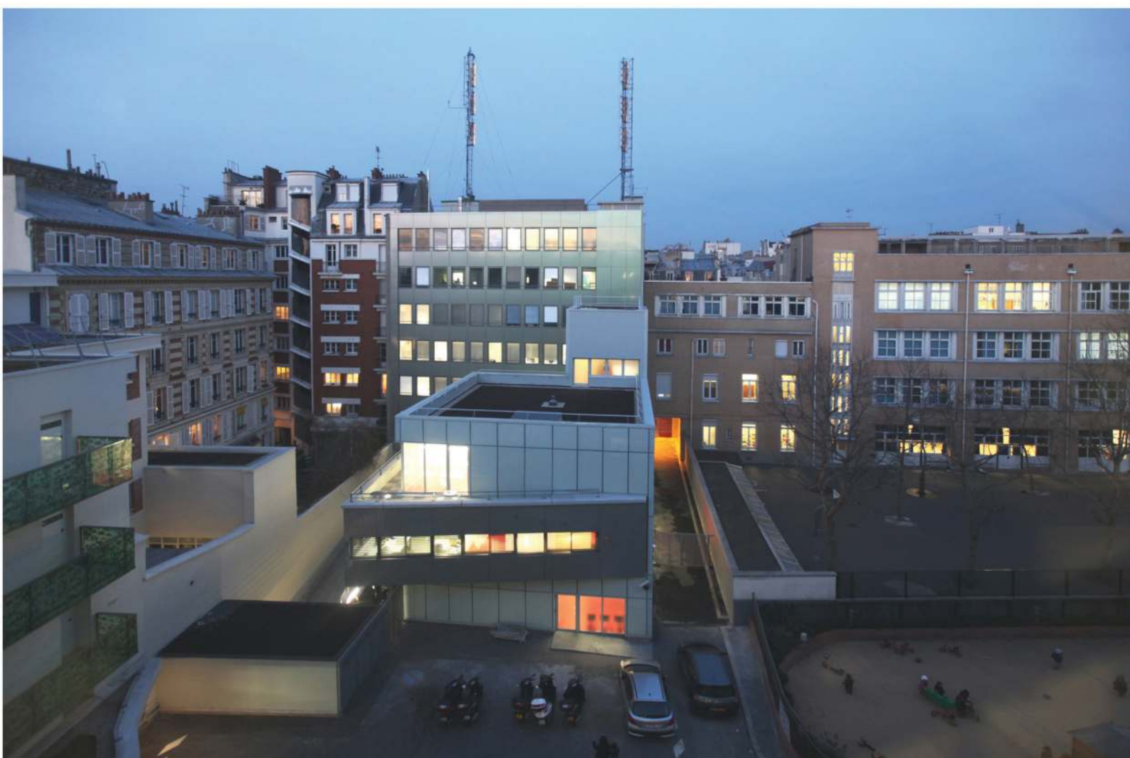
03. Vue générale sur cour, de nuit, depuis la Mairie du 17e.
