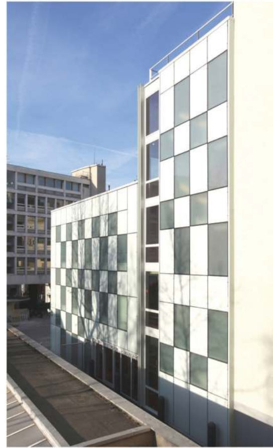
10. Façade en damier, de jour
