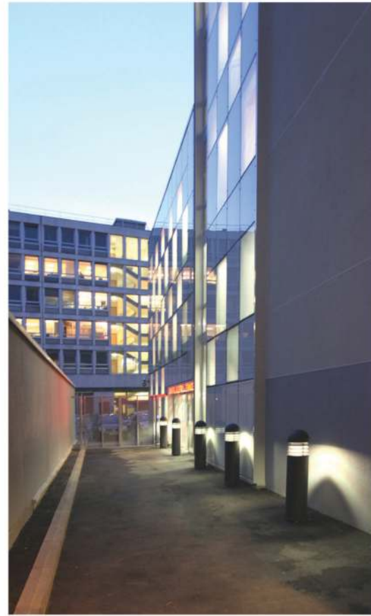
08. Façade en damier, de nuit. Le passage qui traverse l'îlot conduit au C.R.E
