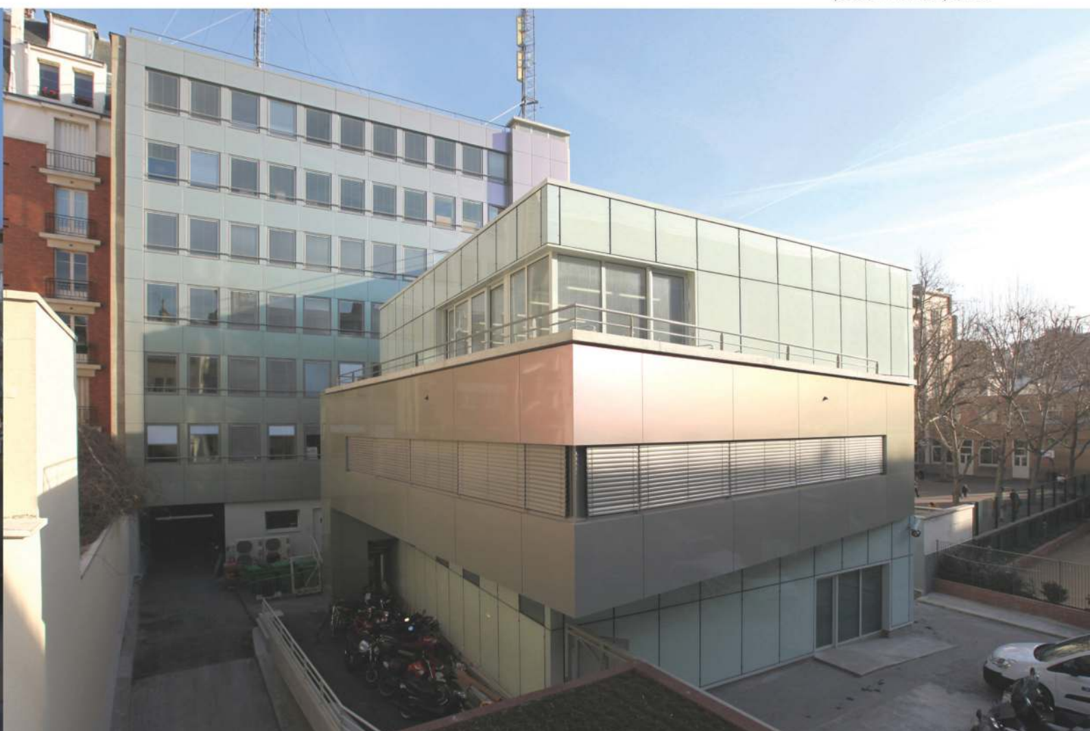
04. Angle sud-ouest du nouveau bâtiment
