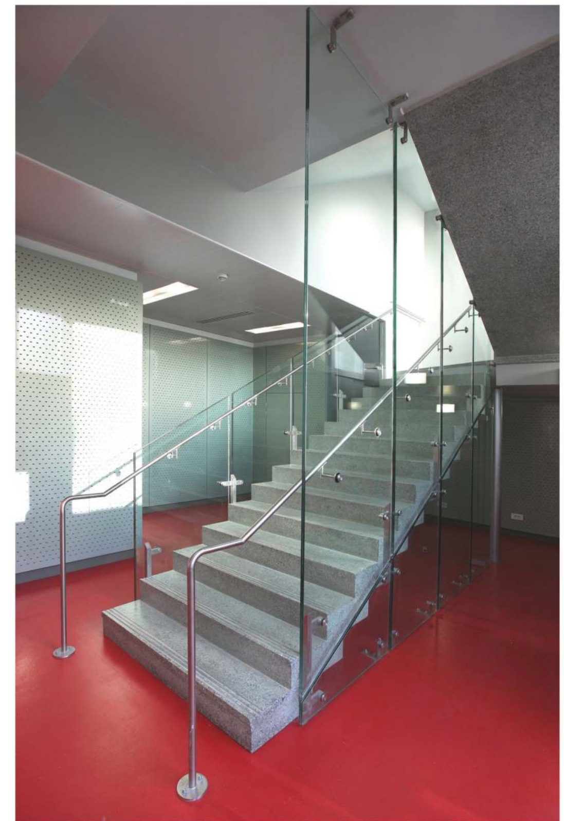
12. Détail de l'escalier du hall du Centre de Réception des Etrangers
