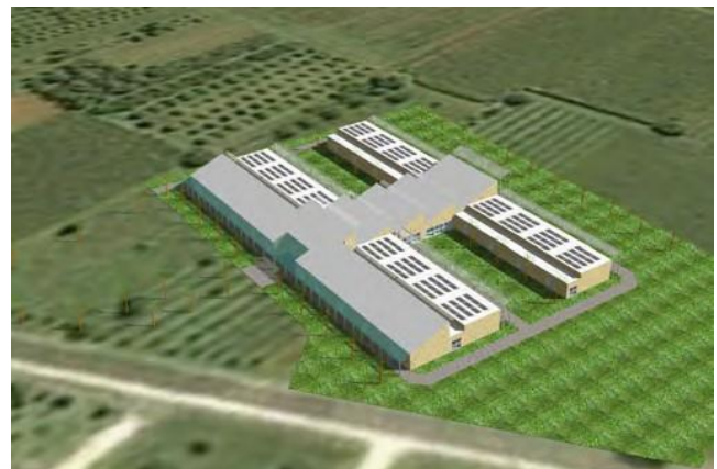
Fig. 38 - La vista da Nord - Ovest mostra invece il porticato in materiale trasparente ed i corridoi di protezione posti sulle facciate Nord e le falde della copertura inclinate verso Nord. Sulla copertura piana delle aule sono posizionati i pannelli solari fotovoltaici. (Progetto Giorgio Bedin)
