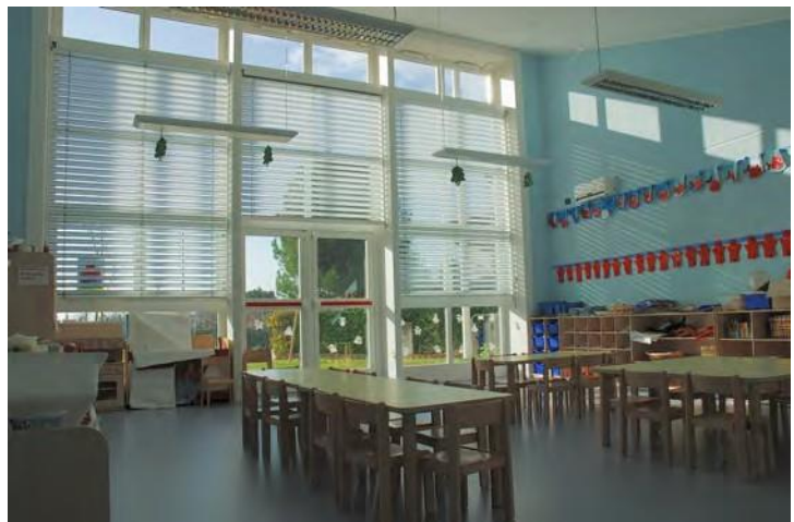
Fig. 46 - La foto di questa sezione di scuola materna scattata in periodo invernale verso mezzogiorno, mostra l'effetto delle lamelle poste internamente alle finestre. Esse infatti, di colore bianco lucido, deviano verso il soffitto la luce solare diretta che altrimenti colpirebbe i banchi di lavoro. Da notare la visibilità dell'atmosfera attraverso le finestre più alte, volutamente lasciate prive di schermature, e la visibilità del giardino attraverso i vetri più bassi. (Progetto Giorgio Bedin - Luca Feltrin)
