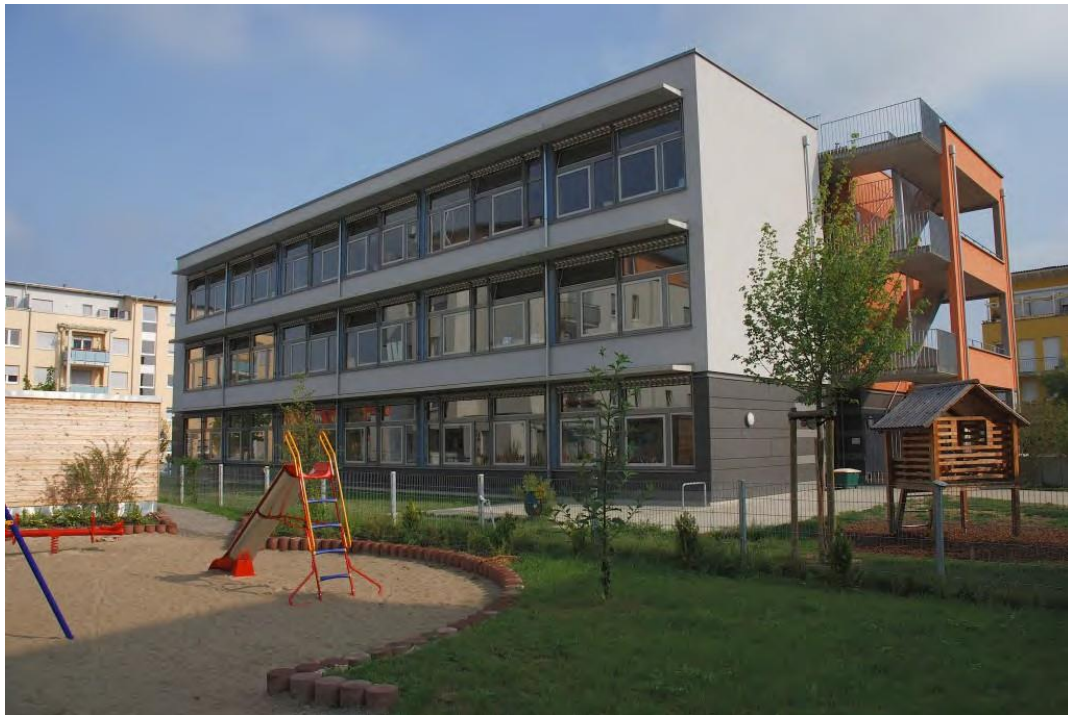
Fig. 22 - Questa scuola elementare dimostra chiaramente i caratteri tipici di un fabbricato solare. Le grandi finestre ricavate sulla facciata Sud sfruttano il guadagno solare diretto e danno molta luminosità. I frangisole sopra le finestre riducono l'insolazione durante i mesi più caldi.
