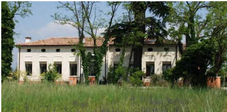
Fig. 3 - Sulla facciata principale orientata perfettamente a Sud, questa ex scuola elementare espone le aule e le finestre
