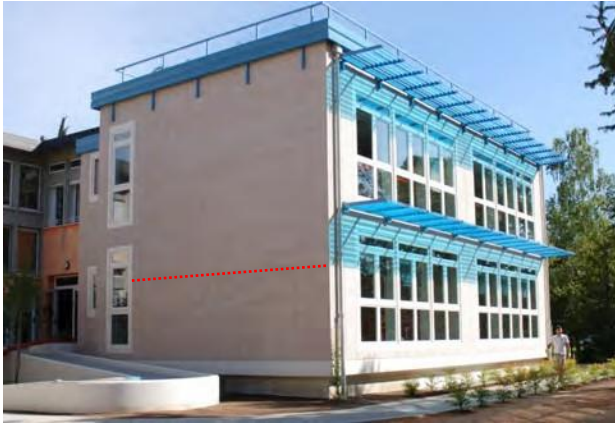
Fig. 56 - Le superfici esterne delle murature di queste quattro aule di una scuola media sono state trattate con materiale lavabile fino a due metri di altezza e idrorepellente fino alla copertura. Il disegno studiato in dettaglio e l'esecuzione accurata della scossalina e del parapetto in copertura hanno evitato successive infiltrazioni d'acqua negli strati della muratura sottostante. (Progetto Giorgio Bedin)
