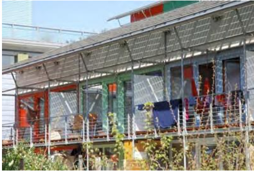
Fig. 15 - 16 Le costruzioni del Villaggio solare sono ben orientate, confidano molto nel rendimento dei numerosi pannelli fotovoltaici in copertura, e sembrano sfruttare il guadagno solare diretto.
