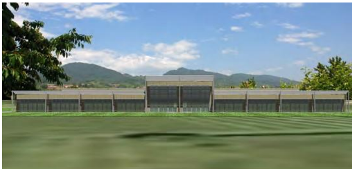
Fig. 72 - La corretta progettazione delle schermature solari in questo progetto di scuola elementare mette completamente in ombra tutte le facciate dei vani esposte a Sud.
