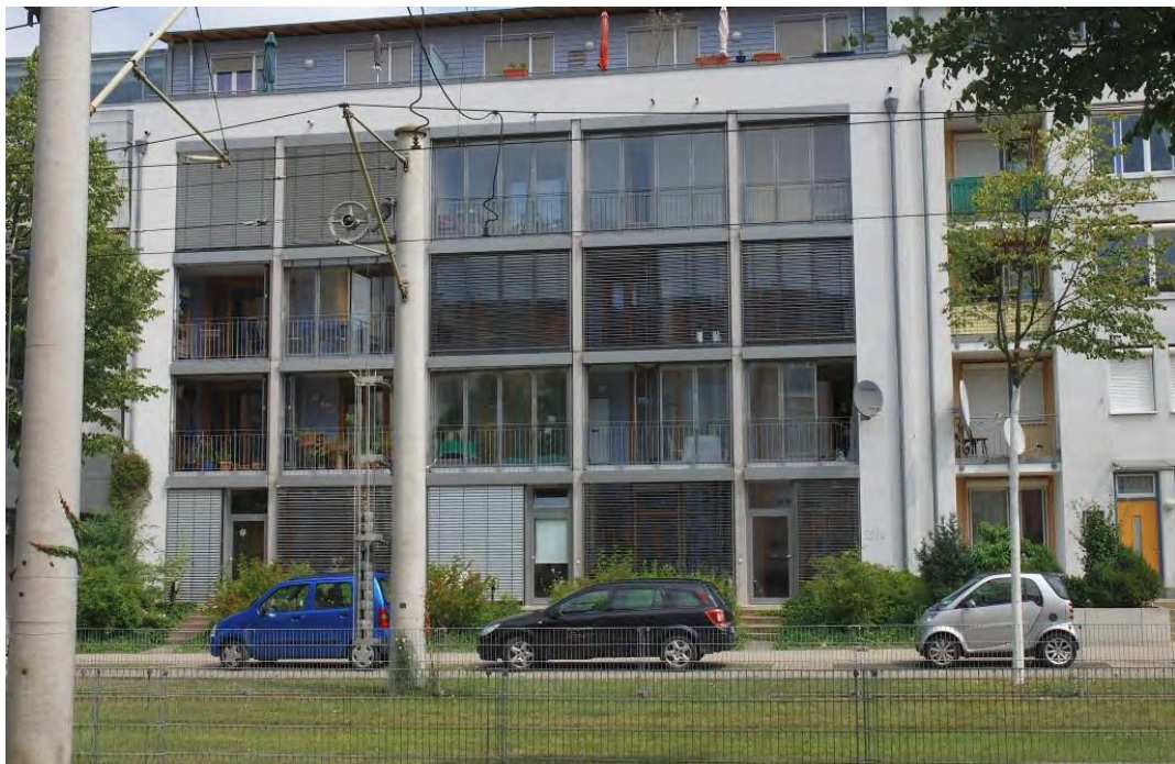
Fig. 23 - Molto interessante la soluzione adottata per la parete Sud di questo edificio, dove sono state ricavate delle logge con doppia vetrata. Serre solari vivibili in inverno, con funzione di guadagno solare utile anche per l'alloggio retrostante. La vetrata esterna aperta in estate lascia in ombra tutta la superficie interna. La vetrata esterna chiusa in inverno permette di utilizzare la loggia, ma anche di aprire completamente la vetrata interna e lasciar passare tutta la luce solare fino all'ambiente interno. A mio avviso le veneziane se collocate internamente avrebbero consentito di deviare i bassi e abbaglianti raggi solari senza perdere gli apporti solari termici. Sembra evidente che i residenti apprezzino il fatto che la luce solare diretta entri in profondità negli alloggi in inverno, anche se proveniente da posizioni del sole molto vicine all'orizzonte.
