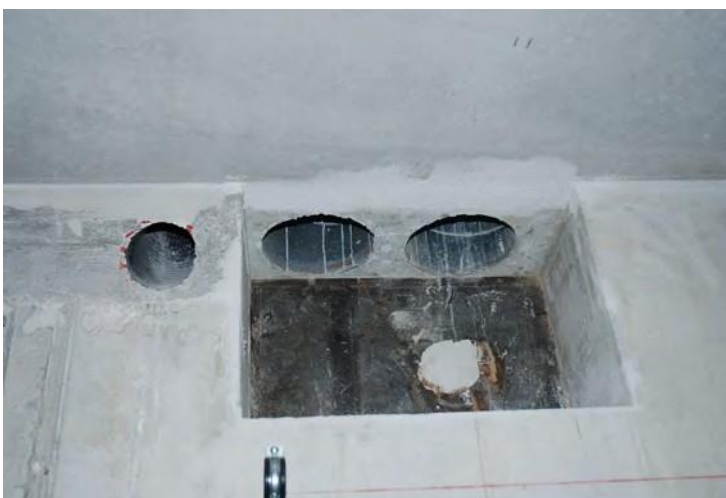
Fig. 55 - Le due condotte d'aria per il ricambio e il tubo flessibile per l'alloggiamento delle tubazioni delle pompe di calore, sono state predisposte entro le murature portanti in calcestruzzo assieme a tutte le condotte degli altri impianti nella costruzione di una scuola materna.
