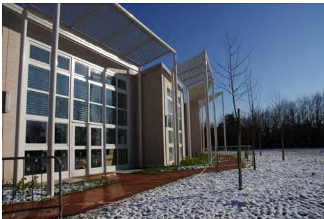
Fig. 50 - L'inclinazione verso Nord della copertura di questa scuola materna ha consentito di aumentare la superficie delle finestre lungo la parete Sud, di ridurre l'altezza della parete Nord e di posizionare le schermature solari estive con il massimo dell'efficacia. (Progetto Giorgio Bedin - Luca Feltrin)
