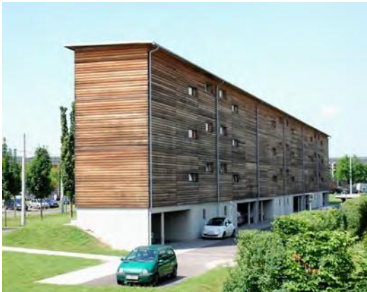
Fig. 33 – Tra tutti gli edifici, quelli costruiti e tamponati con elementi leggeri in legno e metallo, hanno dato le prestazioni energetiche inferiori. Inoltre, le facciate in legno esposte alle intemperie provenienti da Nord, cominciano a mostrare segni di degrado..
