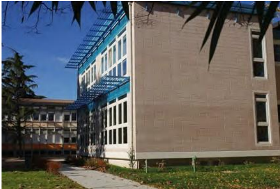
Fig. 49 - Le aperture sulla parete Est delle due aule di questa scuola media (ripetute anche sulla parete Ovest per le altre due aule), aumentano la luminosità interna delle aule medesime senza importanti dispersioni termiche ma consentendo di avere una migliore ventilazione dei locali.
