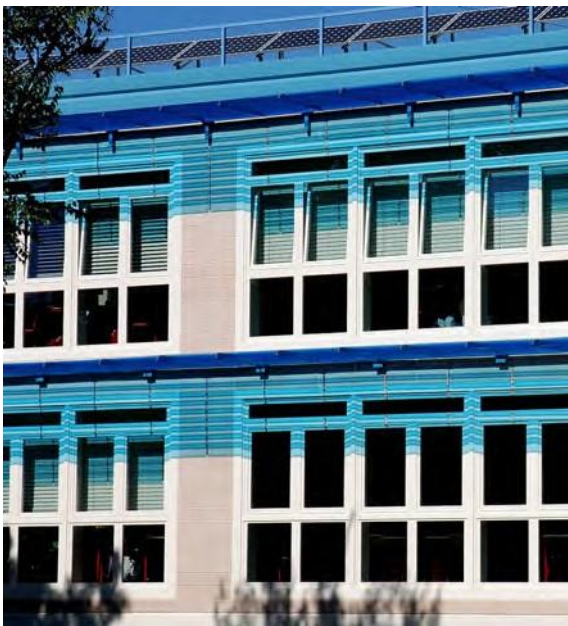
Fig. 39 - La facciata Sud di queste aule di scuola media contiene gli elementi essenziali per la captazione ed il controllo della luce solare diretta. (Progetto Giorgio Bedin)
