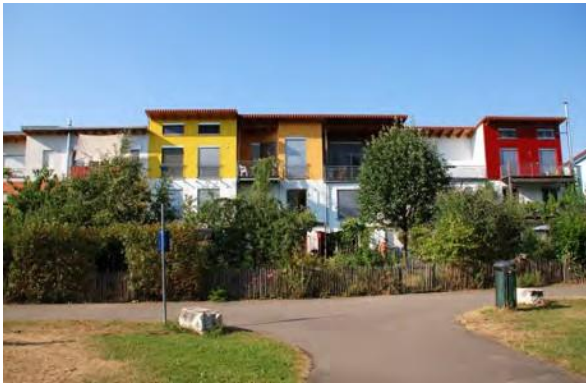
Fig. 24 - Lungo il lato sud del quartiere sono state collocate schiere di case passive. Le loro architetture non denotano particolari caratteristiche riferite all'utilizzo del guadagno solare diretto. Spesso costruite con strutture in legno, esse potrebbero avere difficoltà nel controllo della temperatura interna se non vengono dotate di una notevole massa. Il non poter contare sul guadagno solare diretto, impone però la necessità di utilizzare numerosi impianti spesso complicati.
