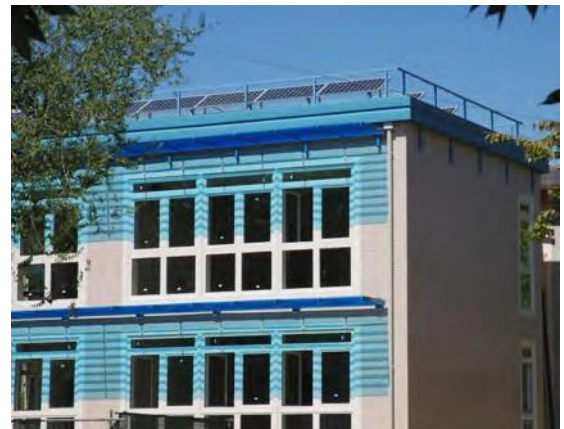
Fig. 51 - Il tetto piano delle quattro aule di questa scuola media, ha permesso di installare su medesimo i pannelli solari fotovoltaici. L'energia prodotta dai pannelli solari è stata calcolata ed è risultata più che sufficiente per il fabbisogno energetico per il riscaldamento, l'illuminazione ed il ricambio dell'aria. (Progetto Giorgio Bedin)
