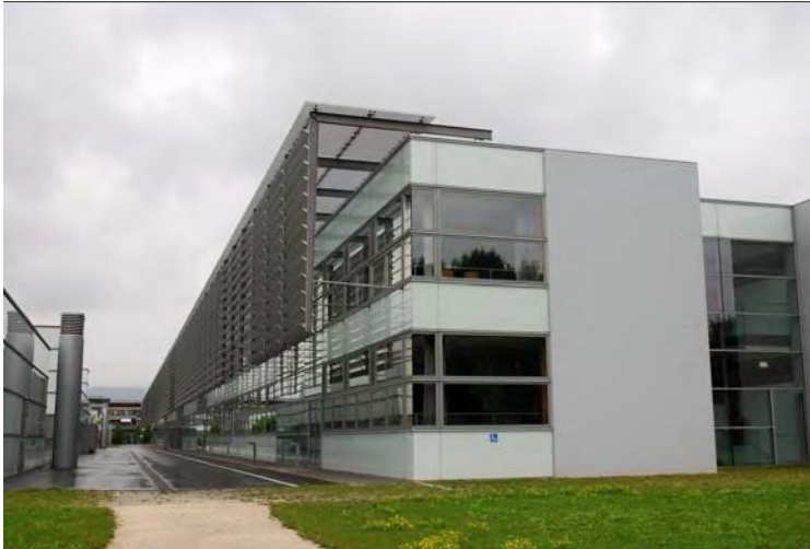
Fig. 34 b – La grande luminosità dei locali ottenibile con una corretta progettazione urbana solare, spesso viene ridotta con soluzioni architettoniche degli edifici alquanto discutibili, come i frangisole orizzontali posti sulle facciate Est ed Ovest di questa scuola. Oltre a rendere difficile il controllo degli effetti indesiderati della luce solare diretta sulle vetrate, al soluzione architettonica riportata impedisce la visione dell'atmosfera abbattendo la luminosità naturale utile e creando l'effetto galleria sui locali interni. La conseguenza è ricorrere alla luce artificiale interna dopo essersi difesi dalla forte luce naturale entrante in direzione indesiderata!
