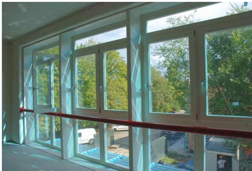
Fig. 40 - La facciata Sud di queste aule di scuola media presenta una soluzione serramentistica che raccoglie le considerazioni espresse e considera anche le necessità di una agevole pulizia dei vetri. La superficie trasparente massima ottenuta e ottenibile garantisce il raggiungimento del FMLD del 3% previsto dalle norme solo al primo piano. Le aule al piano terra sono leggermente penalizzate dalla presenza di un fabbricato ad uso palestra posto in direzione Sud.
