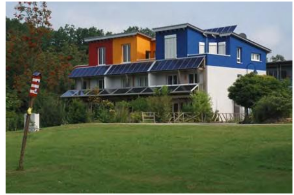
Fig. 24 - Lungo il lato sud del quartiere sono state collocate schiere di case passive. Le loro architetture non denotano particolari caratteristiche riferite all'utilizzo del guadagno solare diretto. Spesso costruite con strutture in legno, esse potrebbero avere difficoltà nel controllo della temperatura interna se non vengono dotate di una notevole massa. Il non poter contare sul guadagno solare diretto, impone però la necessità di utilizzare numerosi impianti spesso complicati.
