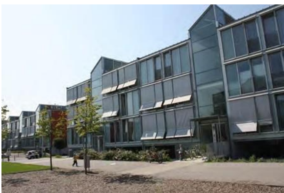
Fig. 34 a – I pochi edifici con esposizione delle finestre ad Est e ad Ovest si devono proteggere in estate dall’irraggiamento solare mattutino e pomeridiano. Gli inquilini devono ricorrere a schermature esterne mobili anche posticce per proteggere gli alloggi e i terrazzini dall’irraggiamento eccessivo. Sulle facciate esposte ad Est ed ad Ovest gli effetti negativi della luce solare diretta sono difficilmente controllabili. Pochi sono i vantaggi dovuti all’irraggiamento solare diretto invernale.
