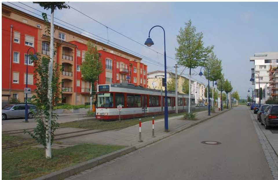
Fig. 21 - Grandi condomini a risparmio energetico sorgono ai lati dalla strada principale parallela alla linea del tram. Per ridurre i costi di costruzione è stata scelta una elevata densità edilizia. Sul fondo della via inizia la grande riserva naturale.
