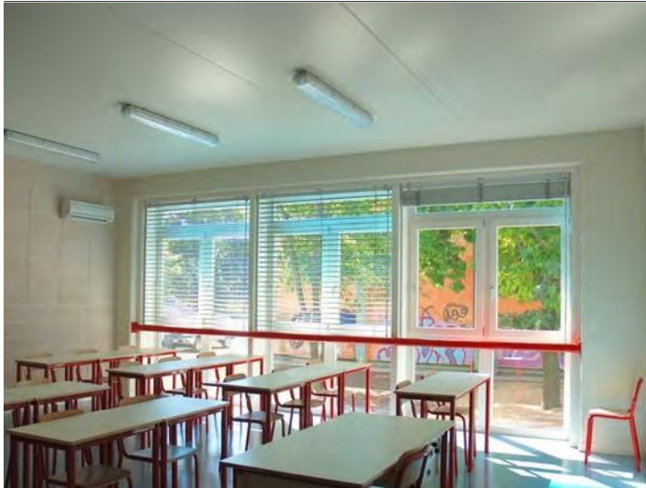
Fig. 45 - La foto di questa aula di scuola media scattata in periodo invernale in un'ora mattutina, mostra l'effetto delle lamelle poste internamente alle finestre. Esse infatti, di colore bianco lucido, deviano verso il soffitto la luce solare diretta che altrimenti colpirebbe i banchi di scuola. (Progetto Giorgio Bedin)
