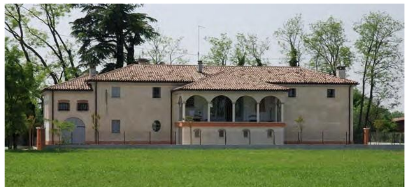
Fig. 4 - Sulla facciata orientata perfettamente a Nord, la ex scuola elementare di Fig. 3 espone solo piccole finestre e aggiunge una loggia di protezione.
