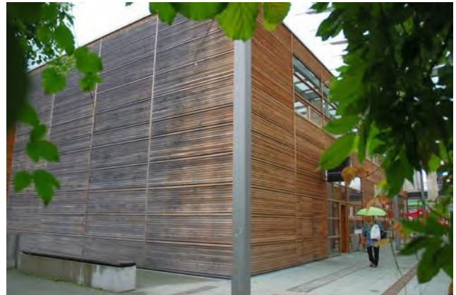
Fig. 33 – Tra tutti gli edifici, quelli costruiti e tamponati con elementi leggeri in legno e metallo, hanno dato le prestazioni energetiche inferiori. Inoltre, le facciate in legno esposte alle intemperie provenienti da Nord, cominciano a mostrare segni di degrado..
