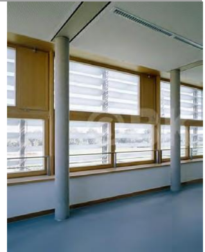
Fig. 34 b – La grande luminosità dei locali ottenibile con una corretta progettazione urbana solare, spesso viene ridotta con soluzioni architettoniche degli edifici alquanto discutibili, come i frangisole orizzontali posti sulle facciate Est ed Ovest di questa scuola. Oltre a rendere difficile il controllo degli effetti indesiderati della luce solare diretta sulle vetrate, al soluzione architettonica riportata impedisce la visione dell'atmosfera abbattendo la luminosità naturale utile e creando l'effetto galleria sui locali interni. La conseguenza è ricorrere alla luce artificiale interna dopo essersi difesi dalla forte luce naturale entrante in direzione indesiderata!
