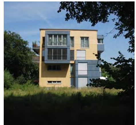
Fig. 14- Le case passive collocate lungo il torrente hanno il privilegio di poter immergersi completamente nel verde e di avere la parete principale rivolta a Sud. In esse i valori di consumo energetico sono molto bassi. Elevata e coerente col percorso del sole è la luminosità naturale. Modalità costruttive particolari e accentuando anche la dimensione delle superfici vetrate esposte a Sud, può condurre a soluzioni ancora migliori dal punto di vista energetico, luminoso e del comfort interno.
