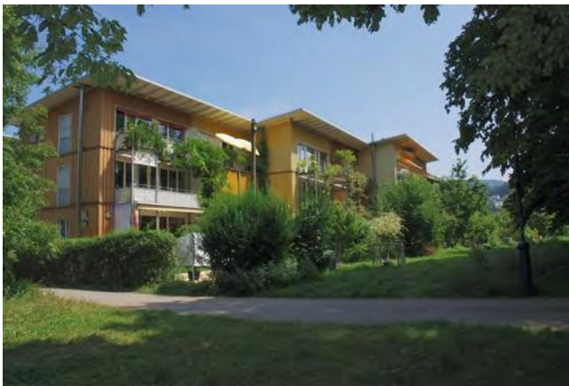
Fig. 14- Le case passive collocate lungo il torrente hanno il privilegio di poter immergersi completamente nel verde e di avere la parete principale rivolta a Sud. In esse i valori di consumo energetico sono molto bassi. Elevata e coerente col percorso del sole è la luminosità naturale. Modalità costruttive particolari e accentuando anche la dimensione delle superfici vetrate esposte a Sud, può condurre a soluzioni ancora migliori dal punto di vista energetico, luminoso e del comfort interno.
