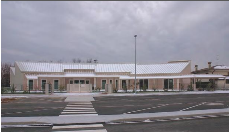
Fig. 47 - La foto della facciata parete nord di questa scuola materna scattata in periodo invernale, mostra la diversa conformazione della medesima rispetto alla parete Sud. Le finestre sono quelle essenziali per soddisfare la richiesta di luminosità interna. Verso Nord sono anche rivolte le falde di copertura. (Progetto Giorgio Bedin - Luca Feltrin)
