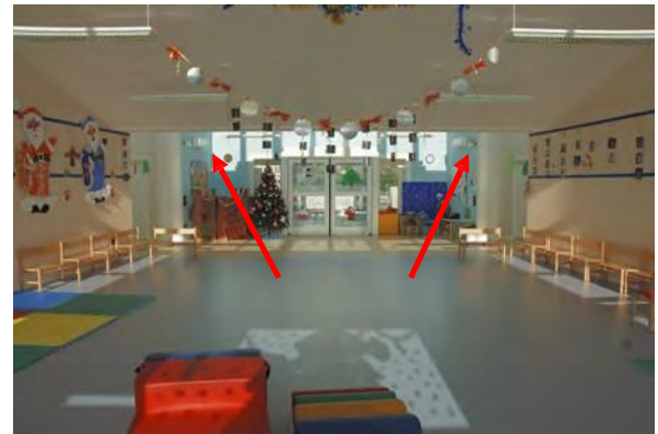
Fig. 105 - Due delle quattro macchine interne di riscaldamento dell'aula per attività libere, collegate ad una sola macchina esterna di adeguata potenza Scuola Materna di Contea. Progetto impianti ing. Giorgio
