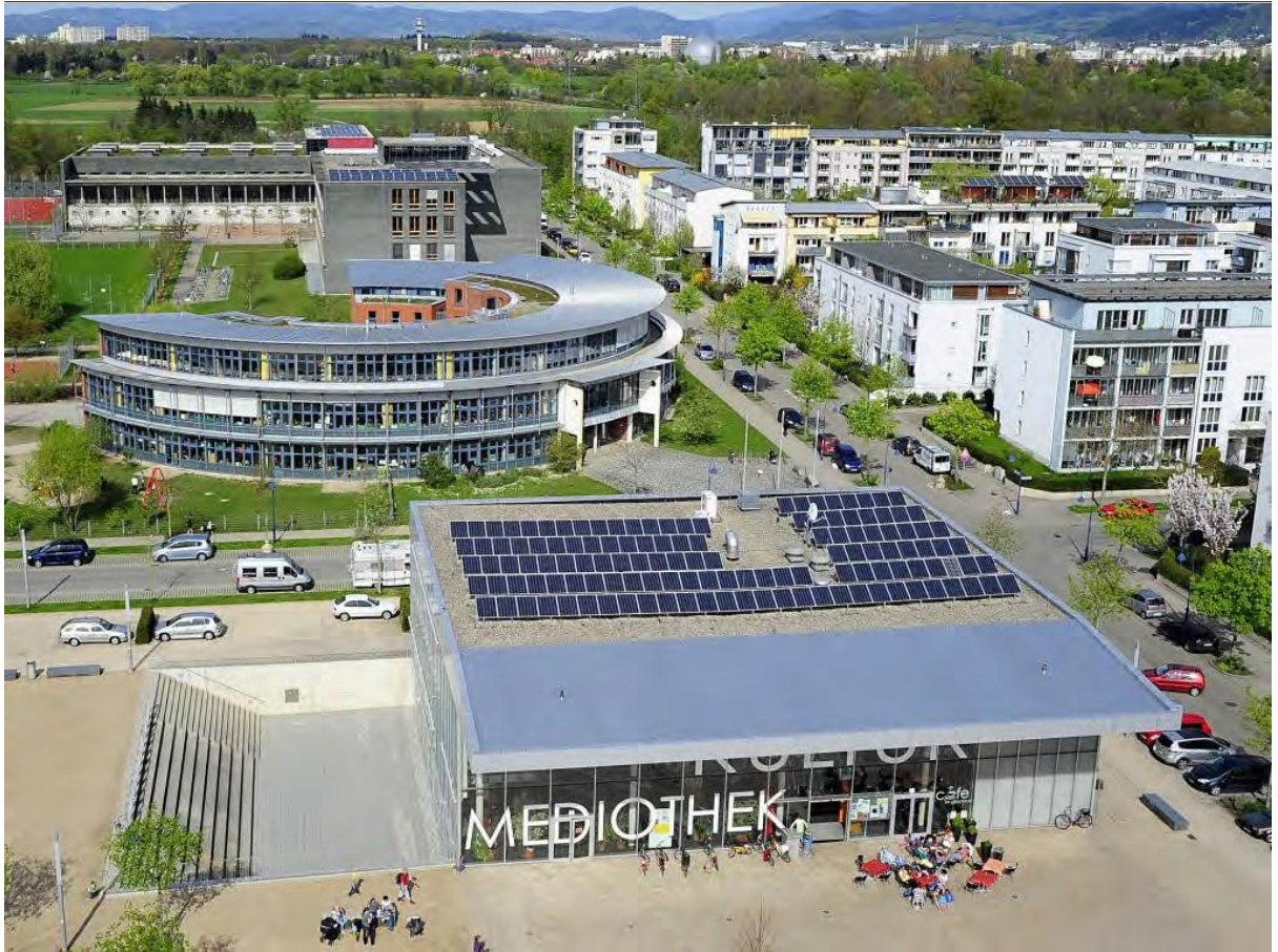
Fig. 20 - Si notano i caratteri marcatamente solari della biblioteca in primo piano e della scuola media retrostante. Meno caratterizzati dal punto di vista "solare" i vicini fabbricati residenziali. La presenza delle auto parcheggiate lungo le strade fa sembrare Rieselfeld più simile alle urbanizzazioni "tradizionali", senza caratteri di sostenibilità, ma il criterio delle precedenze e la bassa velocità dei veicoli (30km/h), facilità enormemente la mobilità, restituendo al quartiere una forte dimensione naturale.
