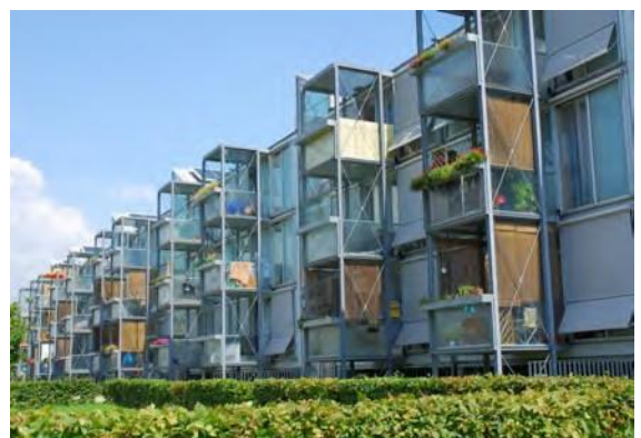
Fig. 34 a – I pochi edifici con esposizione delle finestre ad Est e ad Ovest si devono proteggere in estate dall’irraggiamento solare mattutino e pomeridiano. Gli inquilini devono ricorrere a schermature esterne mobili anche posticce per proteggere gli alloggi e i terrazzini dall’irraggiamento eccessivo. Sulle facciate esposte ad Est ed ad Ovest gli effetti negativi della luce solare diretta sono difficilmente controllabili. Pochi sono i vantaggi dovuti all’irraggiamento solare diretto invernale.
