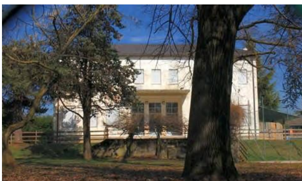
Fig. 6 - Sulla facciata orientata perfettamente a Nord, la ex scuola elementare di Fig. 5 espone solo piccole aperture e le tre finestre necessarie per poter illuminare correttamente il salone centrale
