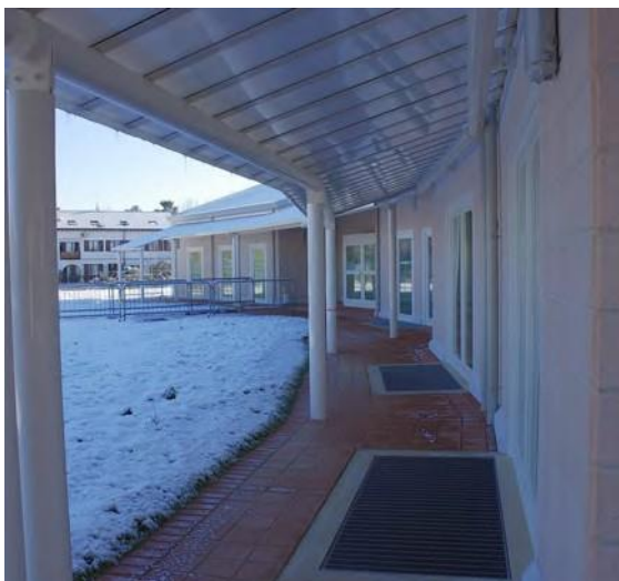
Fig. 48 - Un lungo porticato composto da lastre di polycarbonato protegge tutta la facciata nord di questa scuola materna. Il sciogliersi del leggero manto di neve depositato sulle lastre trasparenti, riporterà la luminosità iniziale sulle vetrate delle finestre. (Progetto Giorgio Bedin - Luca Feltrin)
