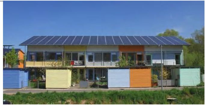
Fig. 15 - 16 Le costruzioni del Villaggio solare sono ben orientate, confidano molto nel rendimento dei numerosi pannelli fotovoltaici in copertura, e sembrano sfruttare il guadagno solare diretto.
