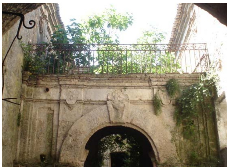
Vista dettaglio corte interna (data 24/05/2008)
