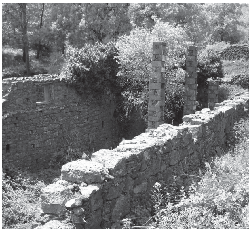
Fig. 2: Restos del edificio B. Bodegas
