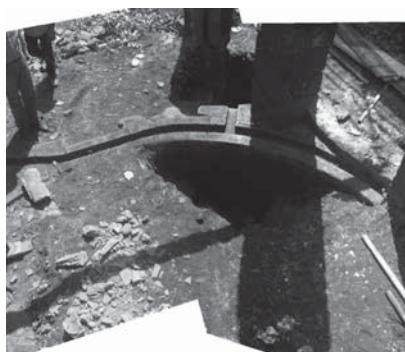
Fig. 3: Trazas. Pavimento en edificio C
