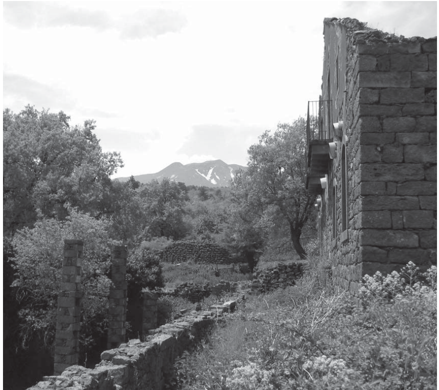
Fig. 1: Restos del edificio B y C, frente al Etna
