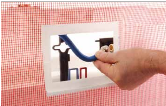
Collegare il tubo flessibile alla valvola di riempimento della cassetta.
