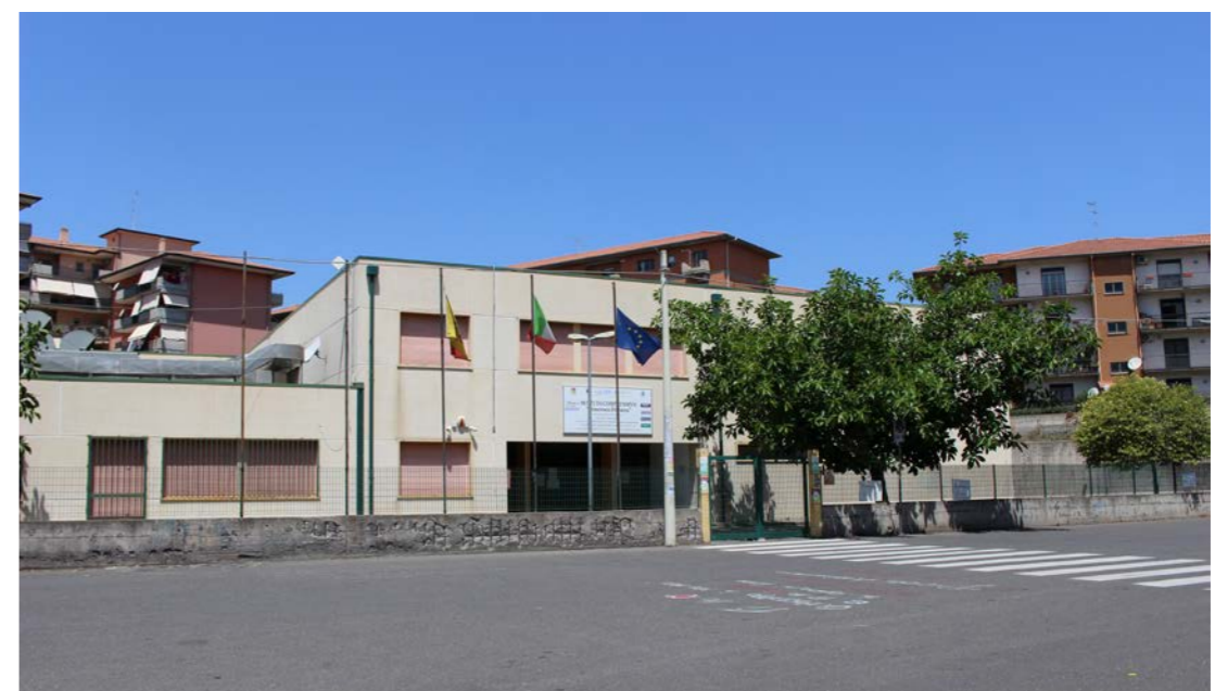
Fig. 45 - Scuola elementare di via Gioviale.
