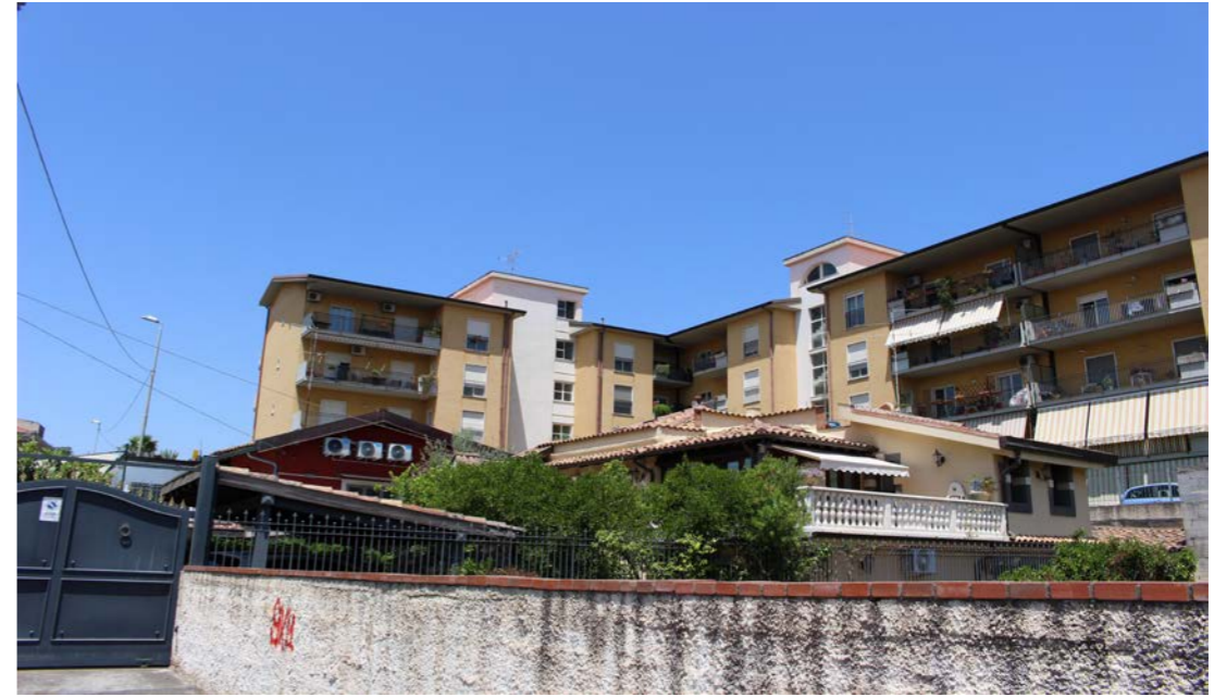
Fig. 6 - Edifici in linea
