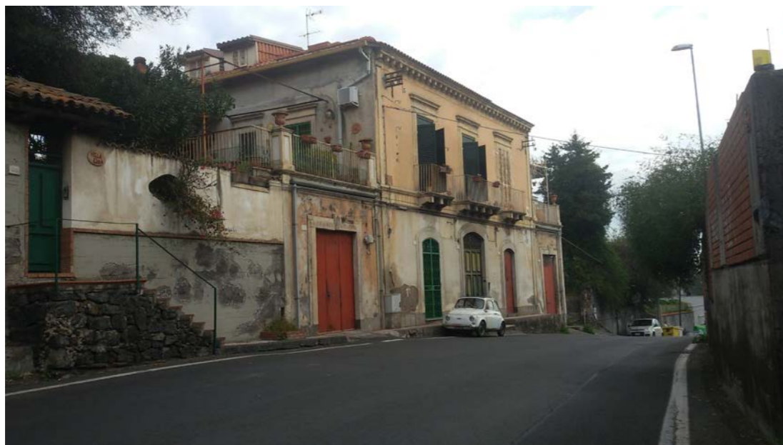
Fig. 5 - Una villa storica in via San Nullo
