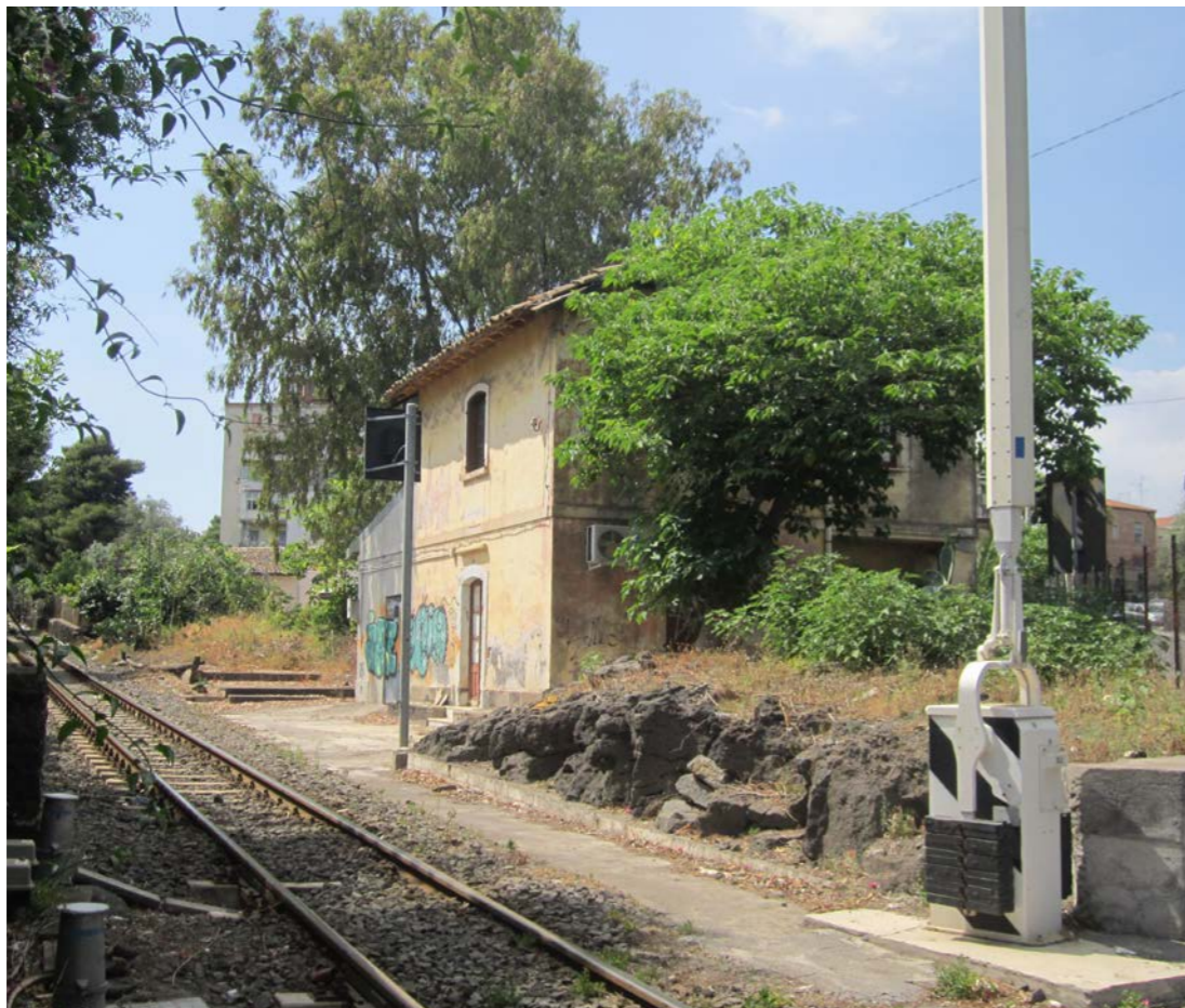
Fig. 27 - Passaggio a livello in via Sebastiano Catania e relativa casa cantoniera dismessa.
