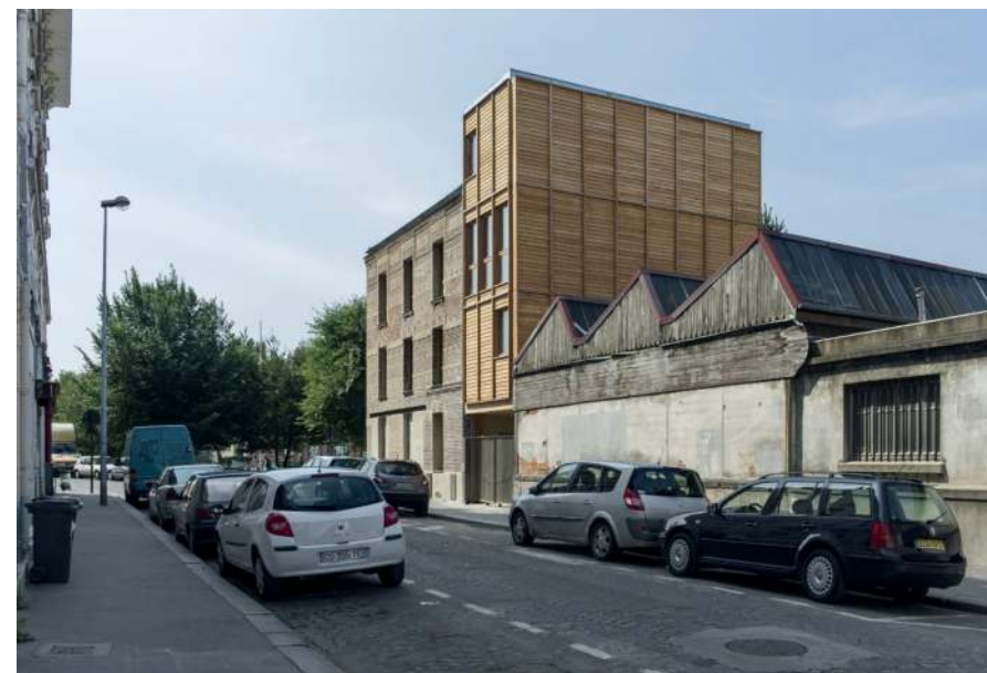
Vue de l'extension depuis la rue Denfert-Rochereau
