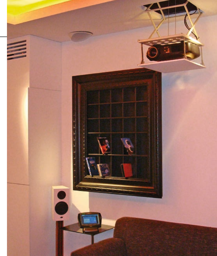
Sopra e nella pagina a fronte, alcune immagini della show-room de Il Satellite; in dimostrazione permanente sistemi audio/video e home automation firmati Denon, Linn, Crestron, ecc. In basso, Cristian Stefanini, titolare del centro.
