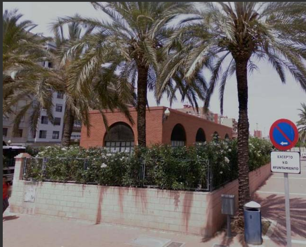
Estación de bombeo de aguas negras del emisario submarino
