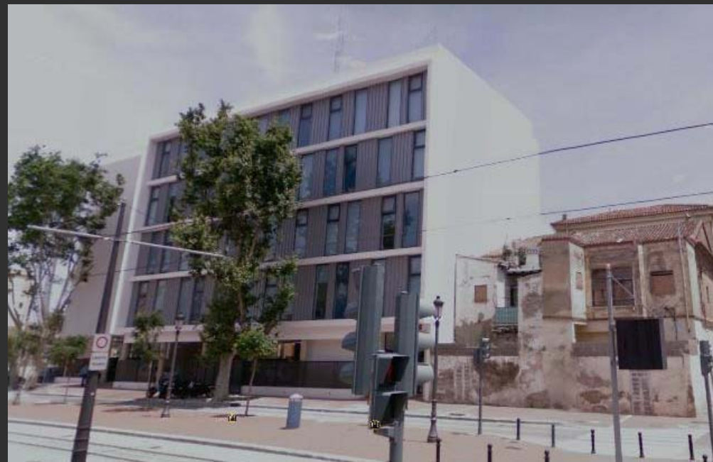
Edificio del ciclo Integral del Agua
