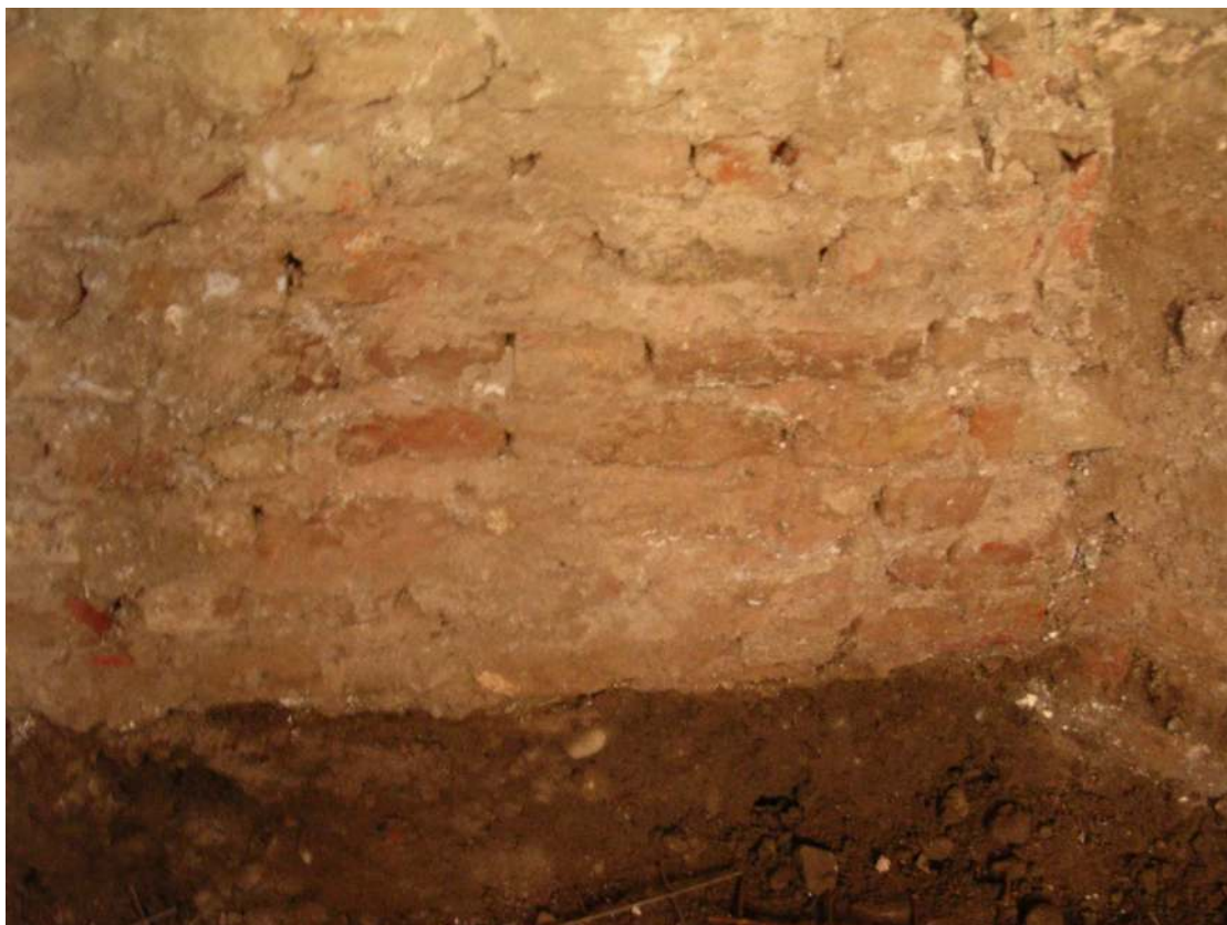
Particolari ravvicinati della muratura
