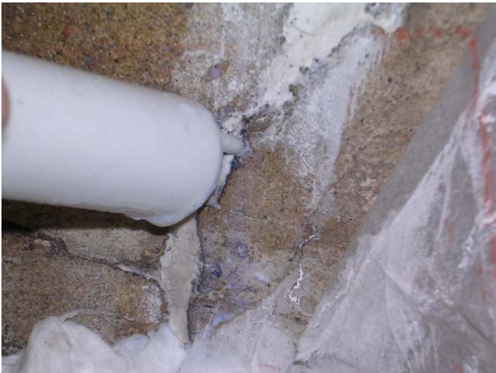
Intervento di preconsolidamento della superficie
