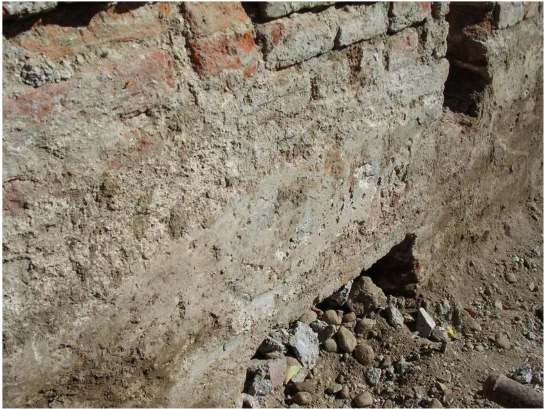
Reperti di intonaco originale. prospetto lato sud della Cappella
