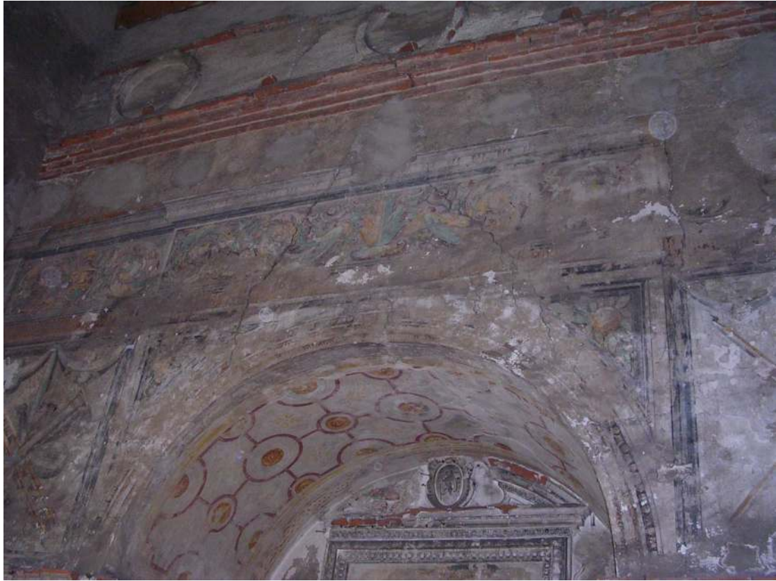
Visione dal basso della parete centrale
