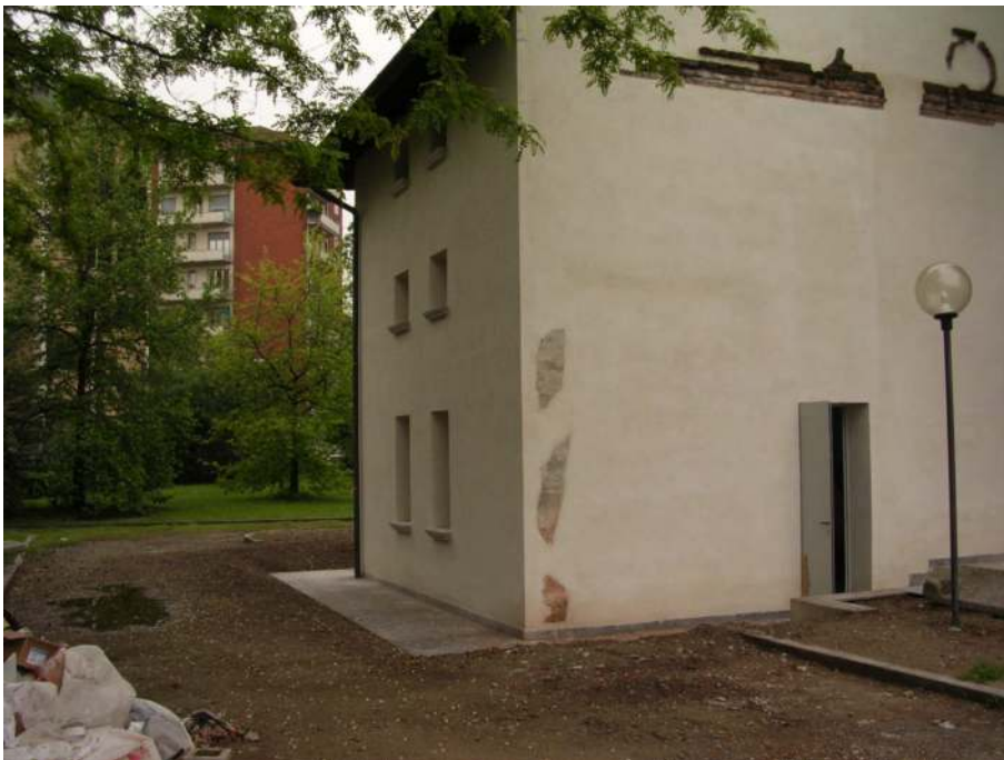
Prospetto esterno lato nord
