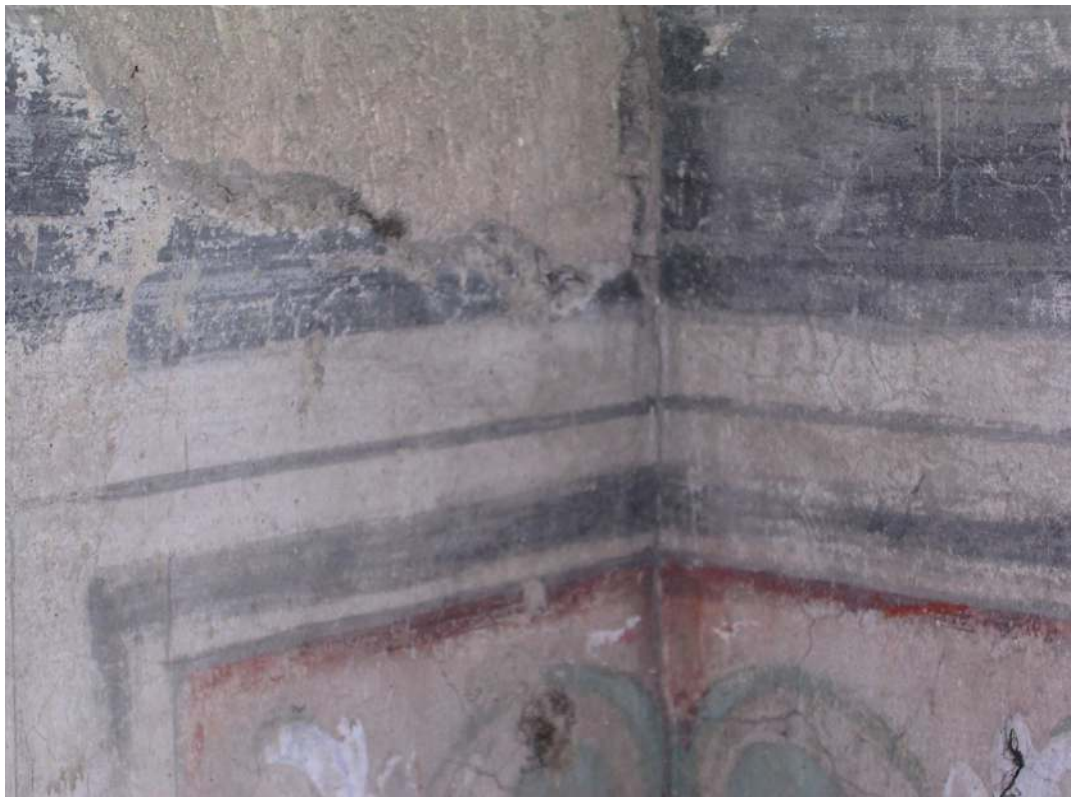
Vedute parziali dell'angolo della cornice superiore
