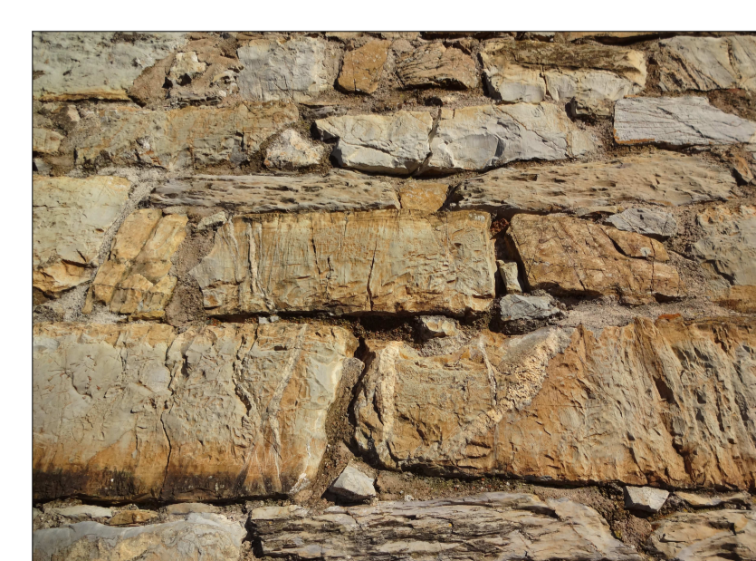
Dettaglio della muratura alla base della torre quadrangolare definibile "cicopica"
