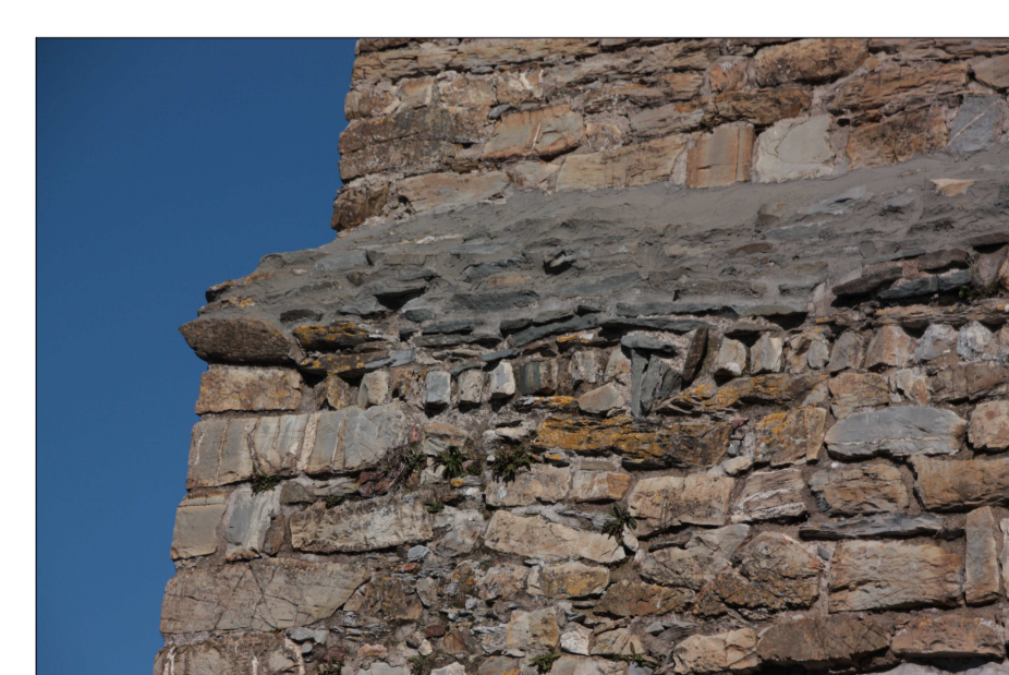
Rastrematura della muratura e decorazione a dente di sega
