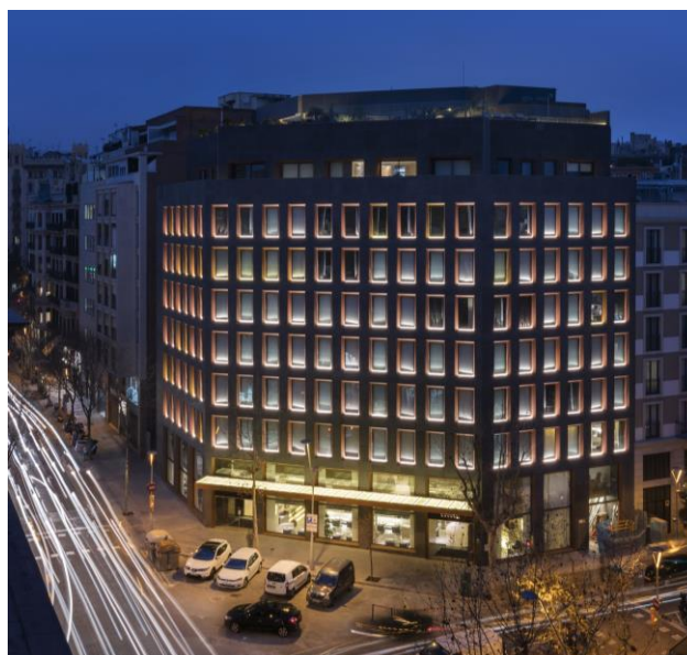
Fachada del hotel The One Barcelona
