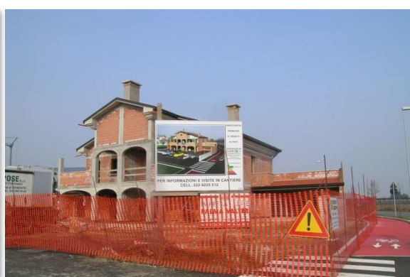
FIGURA 4: EDIFICIO DI NUOVA REALIZZAZIONE IN PROSSIMITA' DELLA ZONA SOGGETTA A TRASFORMAZIONE URBANISTICA
