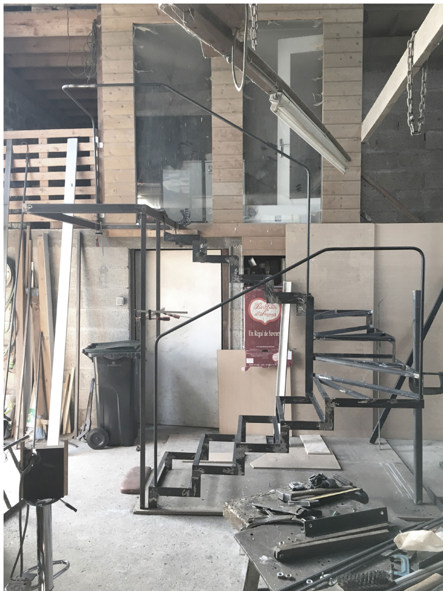
Assemblage de l'escalier principal en atelier, partie supérieure / Assembly of the main staircase in the workshop, upper part Photographie par Office Zola
