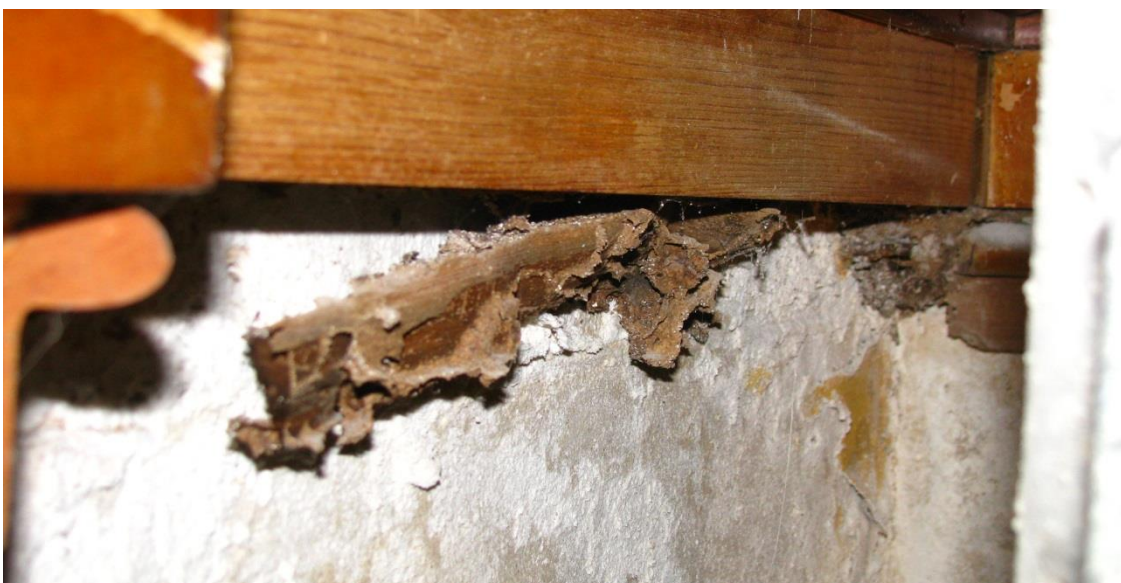
***Acción de las termitas en una de las esquinas superiores del alfarje.
