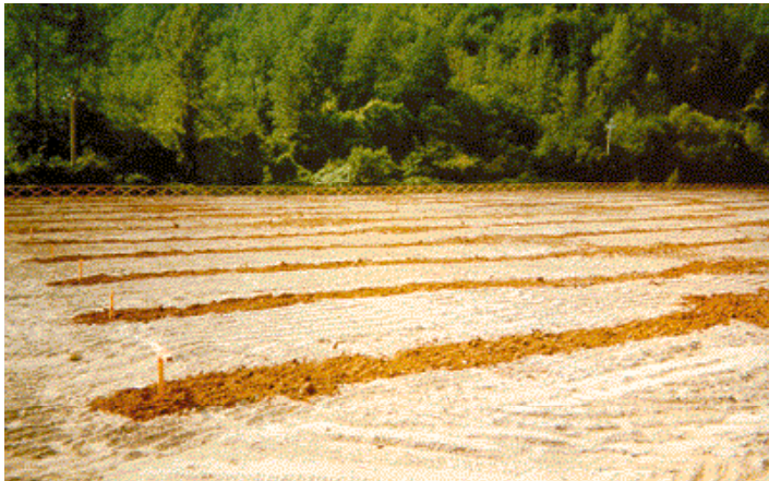
Sistemazione del terreno
