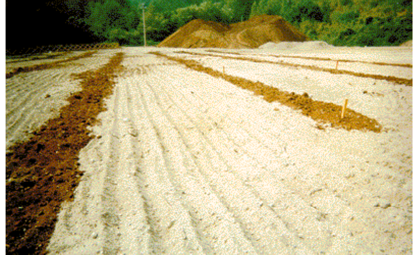
Sistemazione del terreno
