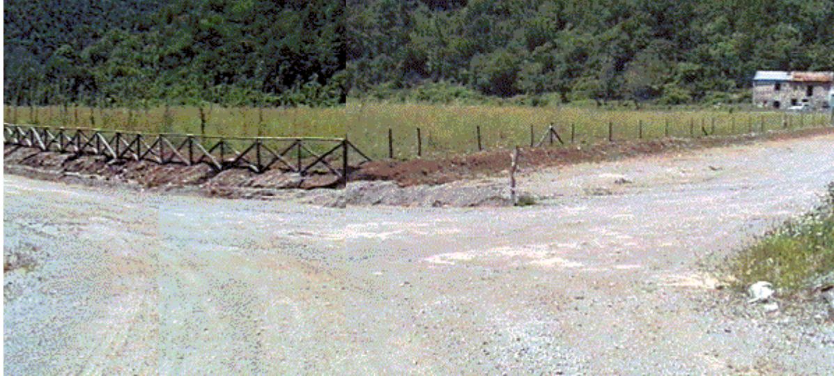
Dopo la lavorazione
