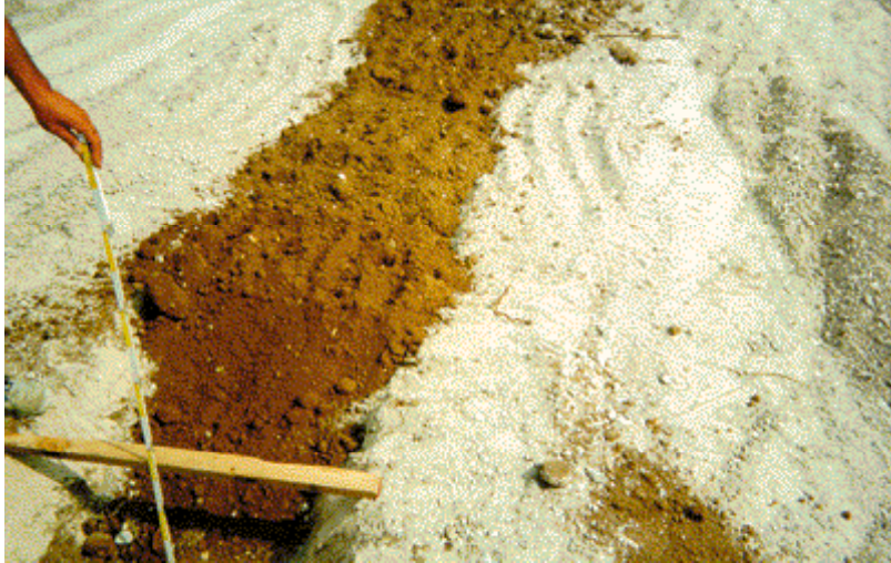
Sistemazione del terreno
