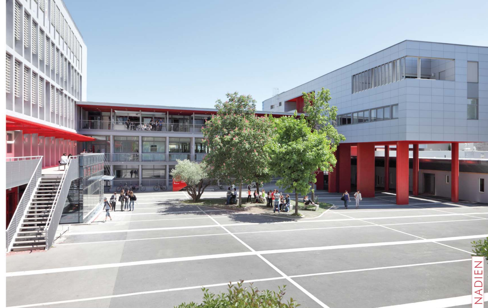
09. Overzicht van de binnenplaats
