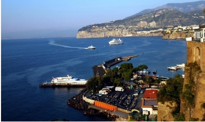
la scogliera flangiflutti e il prolungamento della banchina
