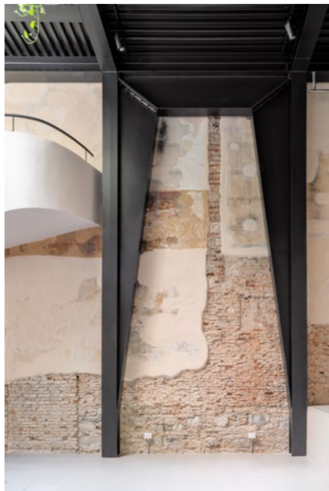
File pt03 | I muri e la nuova struttura della sala principale Foto | Anna Positano e Gaia Cambiaggi
