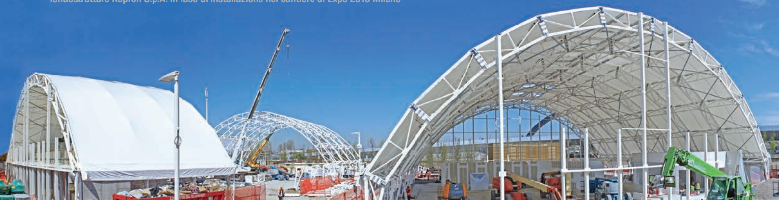
Tendostrutture Kopron S.p.A. in fase di installazione nel cantiere di Expo 2015 Milano
