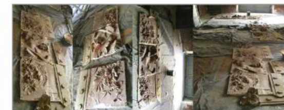
Yeserías puertas jónicas desmontadas
