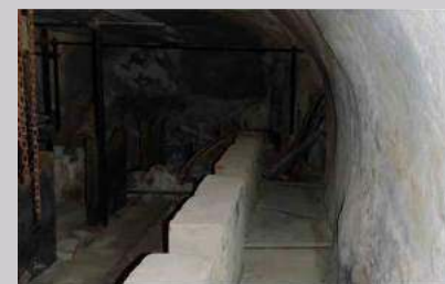
Cantina, particolare dei sostegni per le botti di vino
