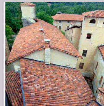
Coperture, vista dall'alto
