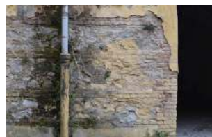
Rilievo fotografico di una porzione del prospetto nord, dove si comprende la tessitura muraria listata
