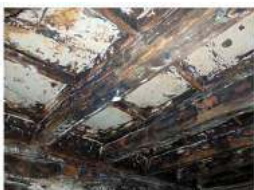
Dettaglio del solaio cassettonato
