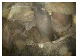
3 Scarico della vasca prosegue in profondità per più di 3m
