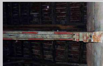
Mensola e intradosso decorati della trave in legno
