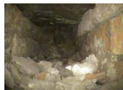
2 Scarico della vasca che prosegue in profondità
