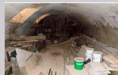
Cantina, vista verso ovest
