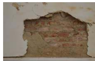
Rilievo fotografico di una porzione di volta da dove è possibile dedurre la tessitura dei mattoni delle volte nel livello 0 e 1
