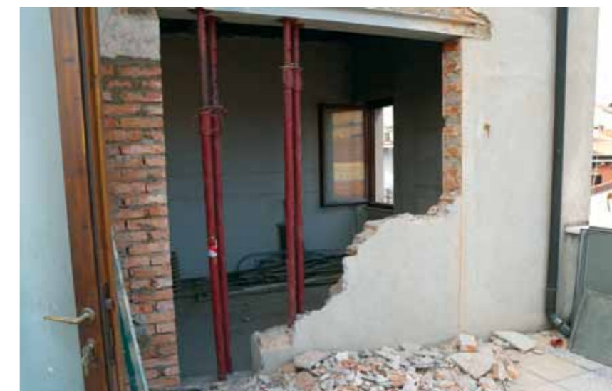
Apertura della porta-finestra sulla terrazza esterna
