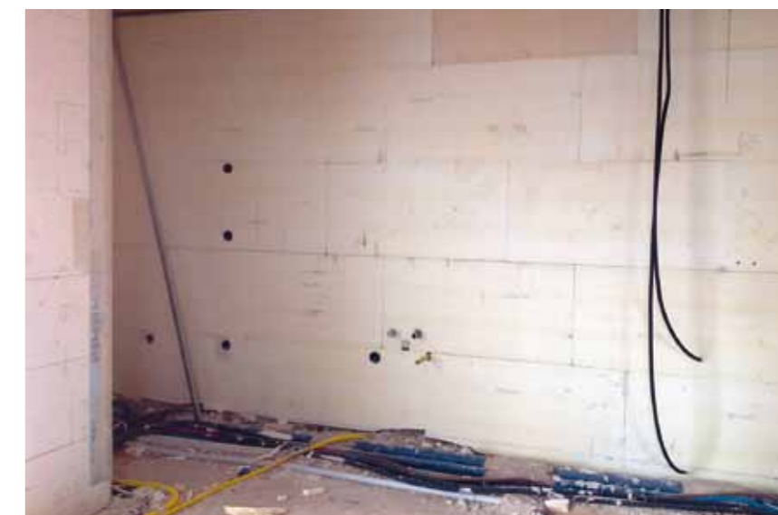
Isolamento delle pareti del vano scala pannelli di poliuretano espanso
