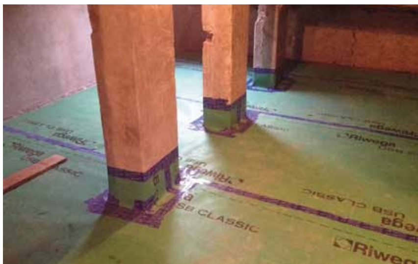
Membrana traspirante su assito esistente, opportunamente nastrata e risvoltata sui muri al piano inferiore
