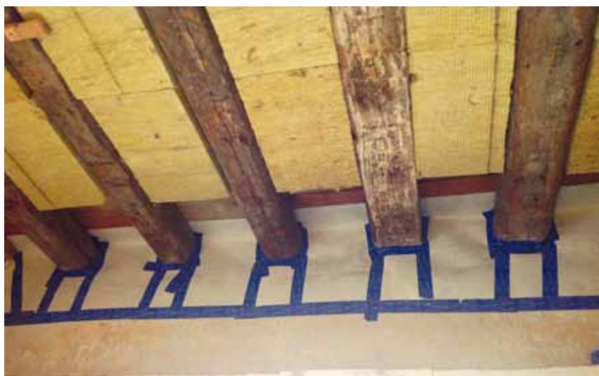
Isolamento del pacchetto di copertura, telo discendente e nastratura di tutti i punti critici
