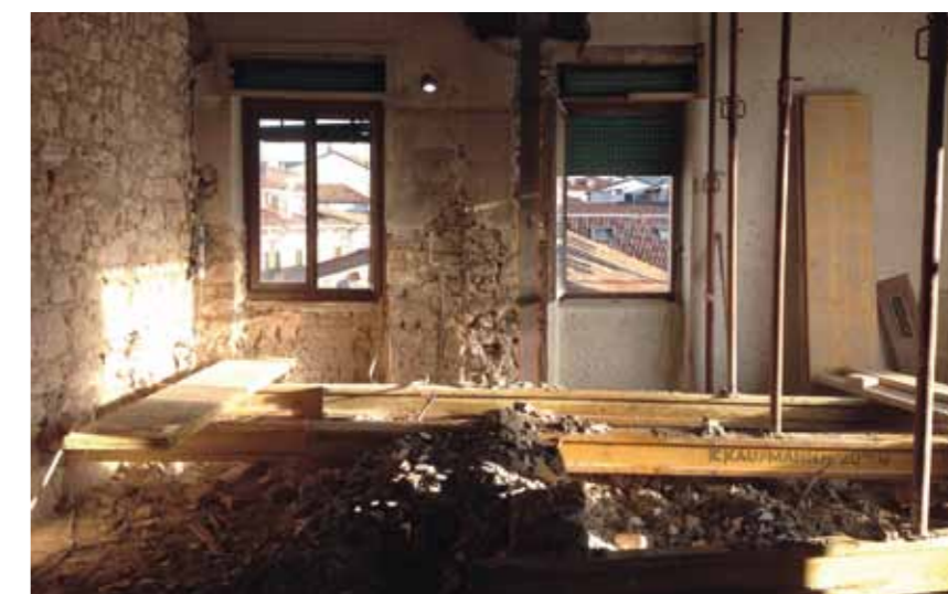
Demolizione dei divisori e posa dei rinforzi
