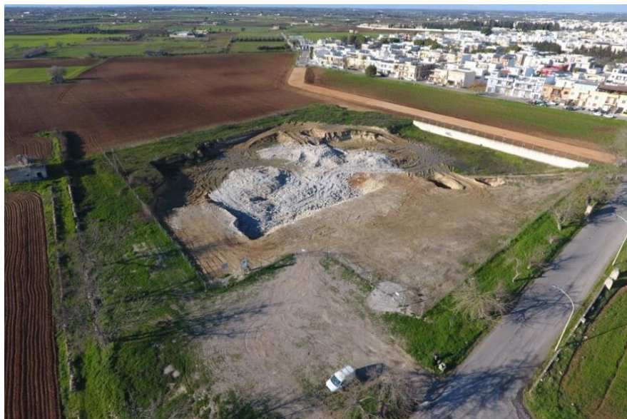
Vista aerea del lotto – post demolizione
