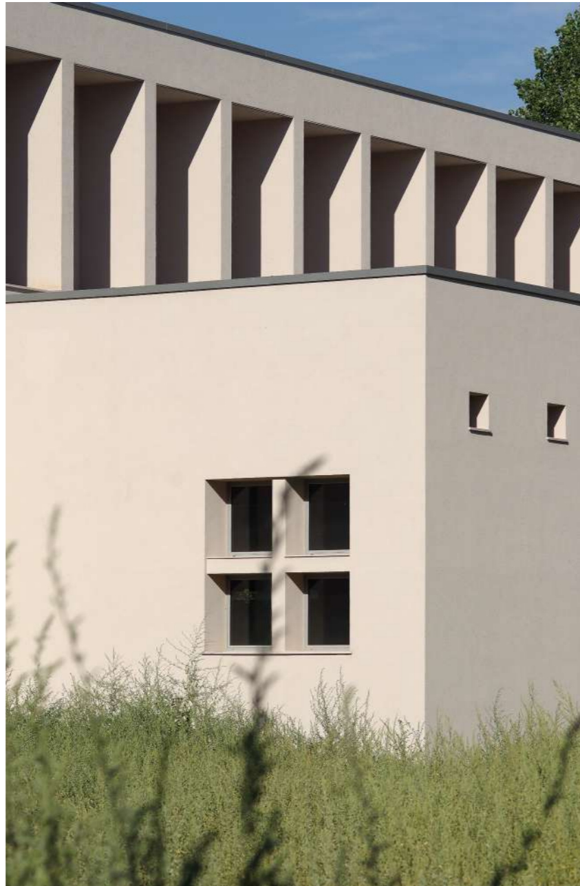
Vista di dettaglio dal giardino, settembre 2021
