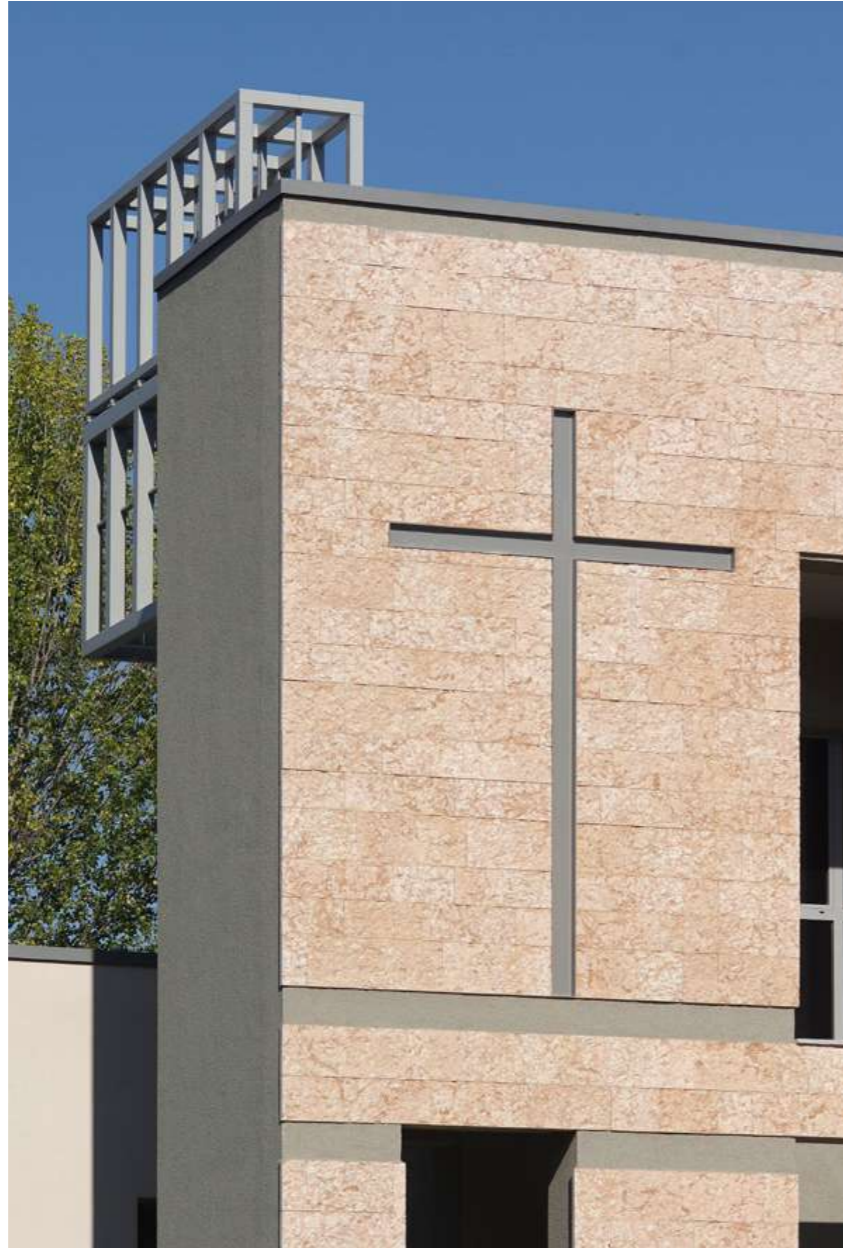
Dettaglio di facciata del narice, settembre 2021
