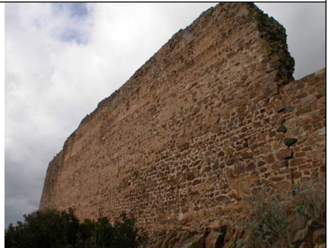
Muratura del Mastio
