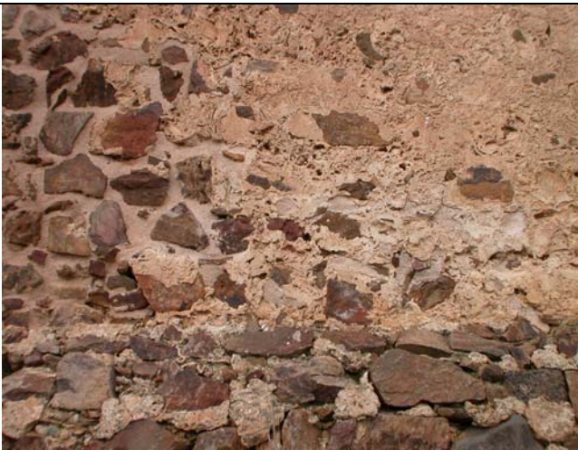
Muratura ed intonaco del Mastio
