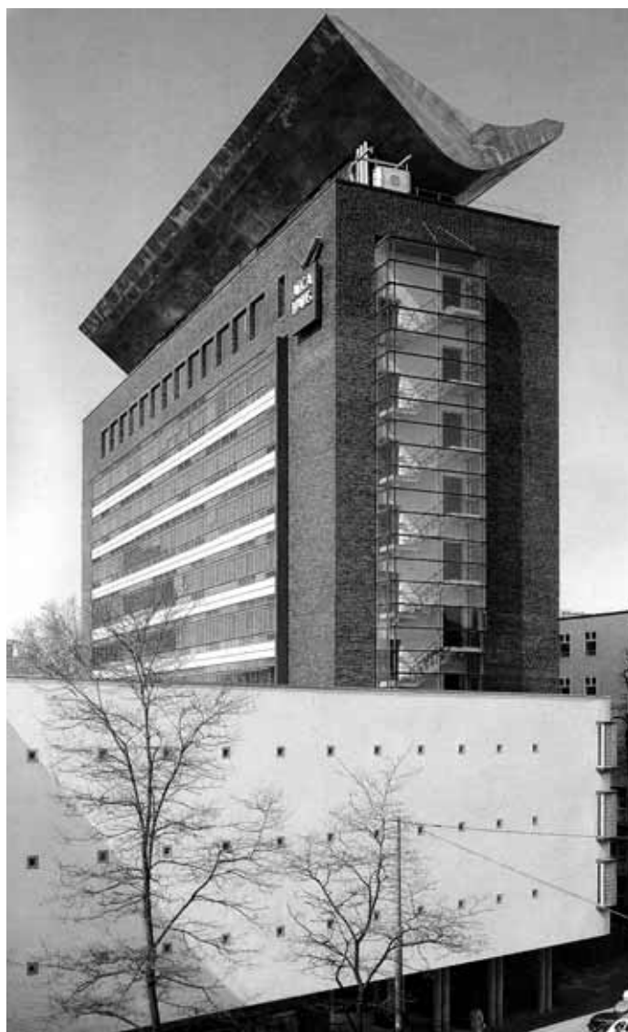
Figure 12 - 13. L'edificio per uffici degli anni Sessanta, a Francoforte sul Meno, prima e dopo l'intervento dell'architetto Christoph Mäckler, realizzato all'inizio degli anni Novanta.
