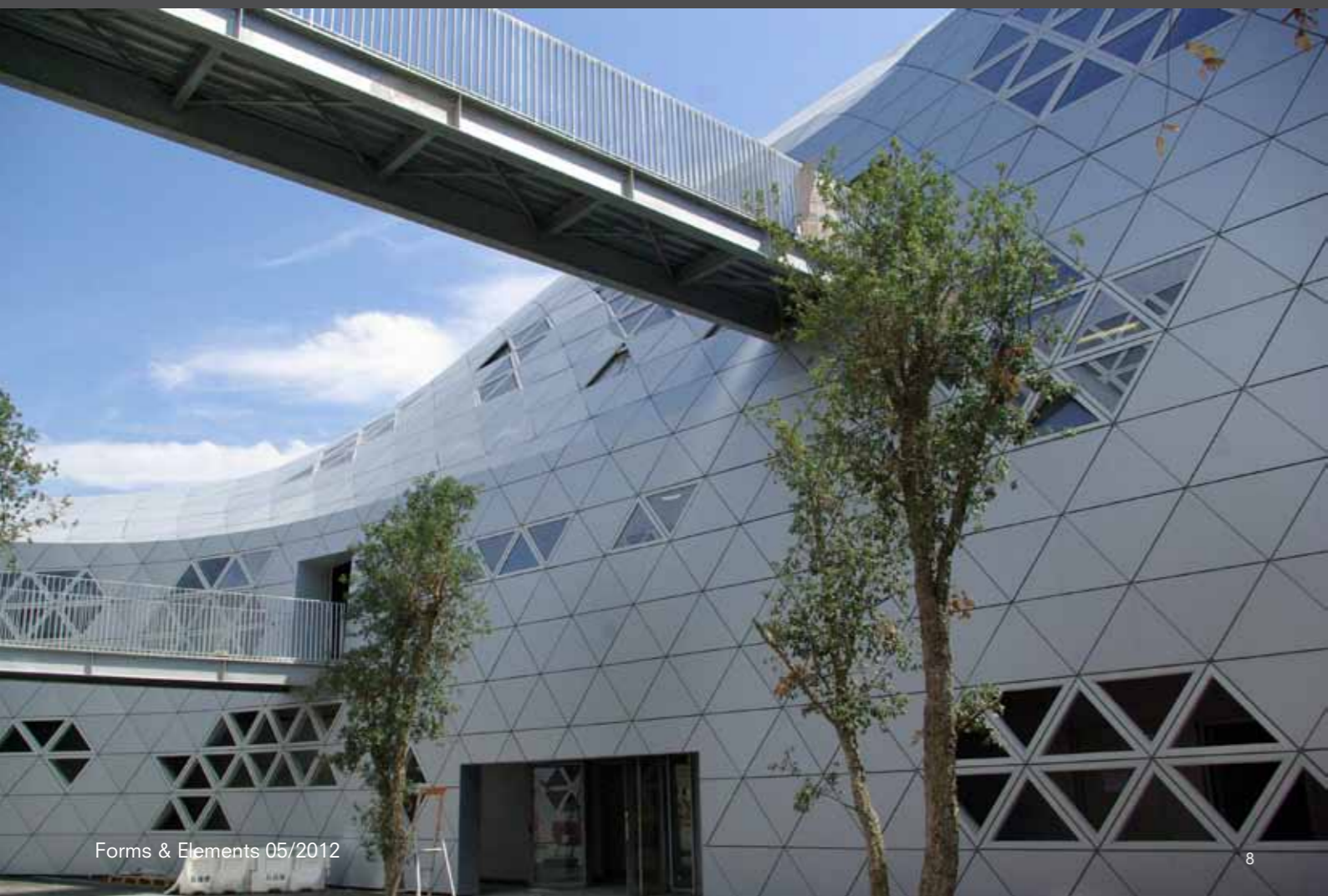
Each of the triangular tray panels is unique. Jede der dreieckigen Kassetten ist einmalig.
