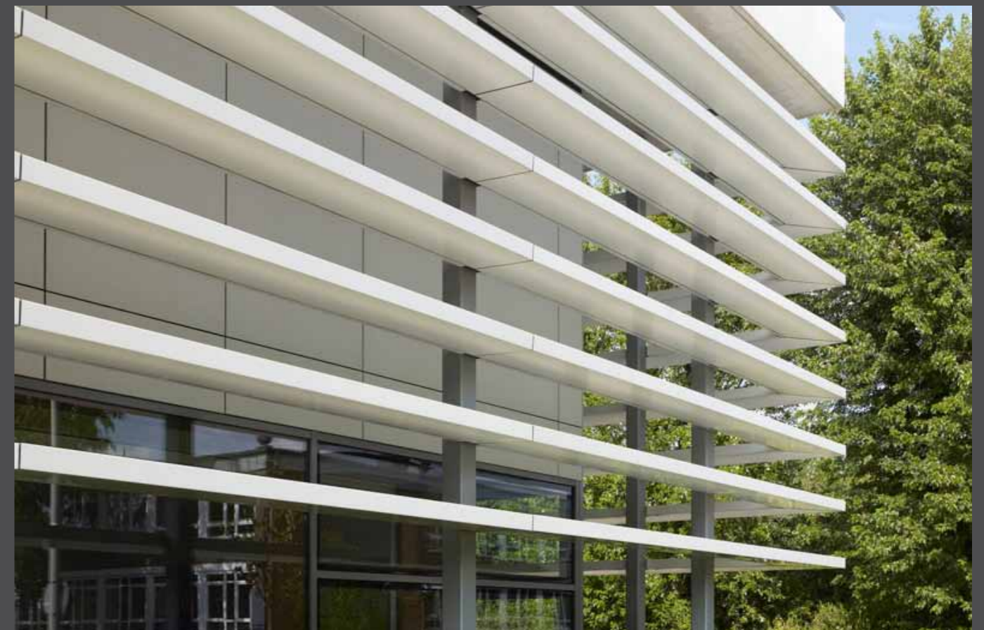
Eye-catching sunblades made with ALUCOBOND®. Sonnenlamellen aus ALUCOBOND® als Blickfang.
