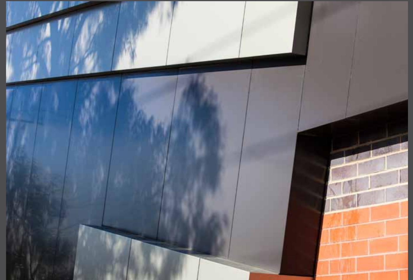
Transition between different cladding materials. Übergang verschiedener Fassadenmaterialien.
