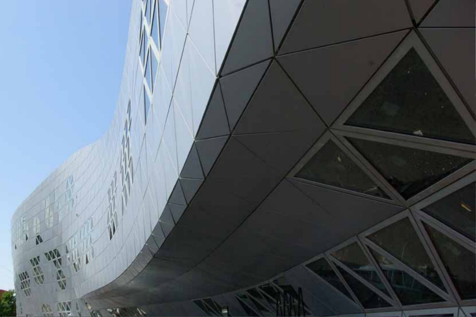
Each of the triangular tray panels is unique. Jede der dreieckigen Kassetten ist einmalig.
