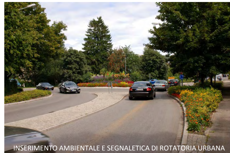
ROTATORIA URBANA DA 18 m DI DIAM. CON CORONA TRANSITABILE
