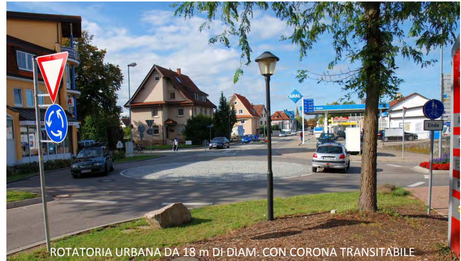
ROTATORIA URBANA DA 18 m DI DIAM. CON CORONA TRANSITABILE
