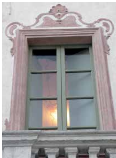
Fig. 18. Cortile interno, inizio lavori
