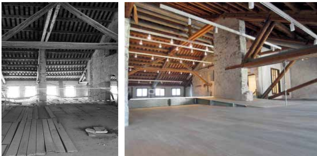
Fig. 8. piano terzo, inizio lavori
