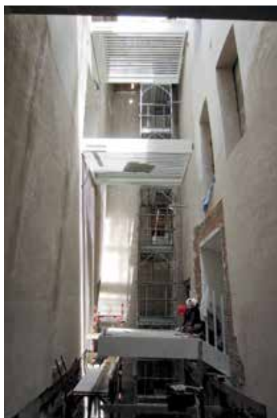
Fig. 3. cavedio interno, inizio lavori
