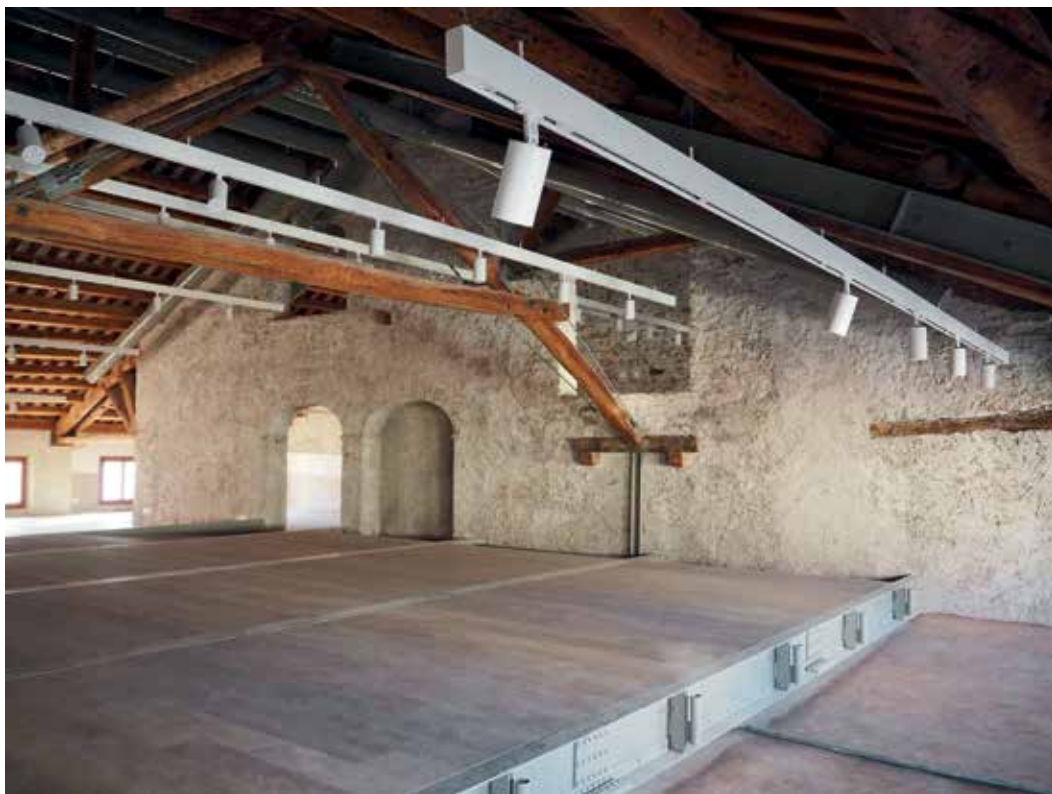
Fig. 11. piano terzo nuovo solaio di calpestio leggermente rialzato, intervento strutturale, fine lavori
