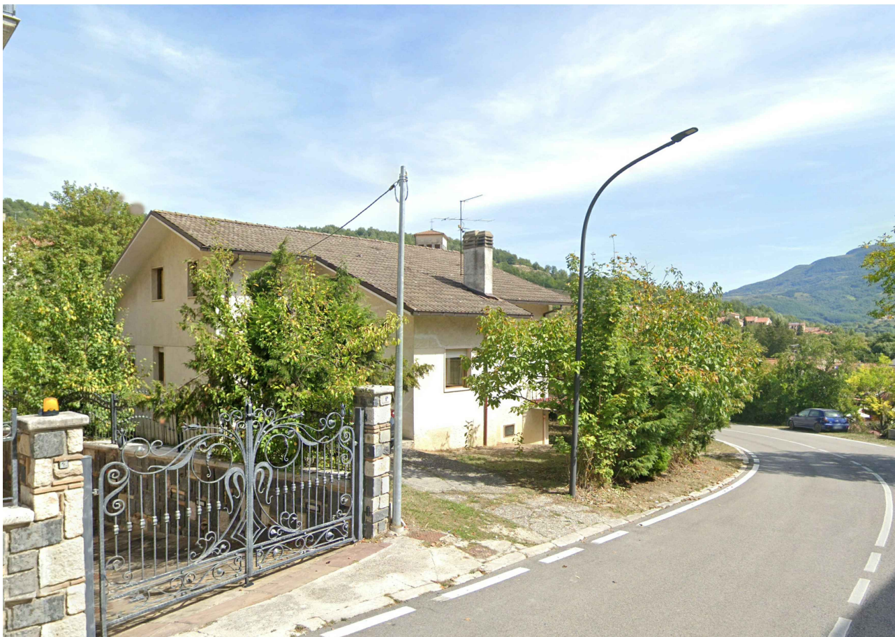
Fotografia - Stato di Fatto
