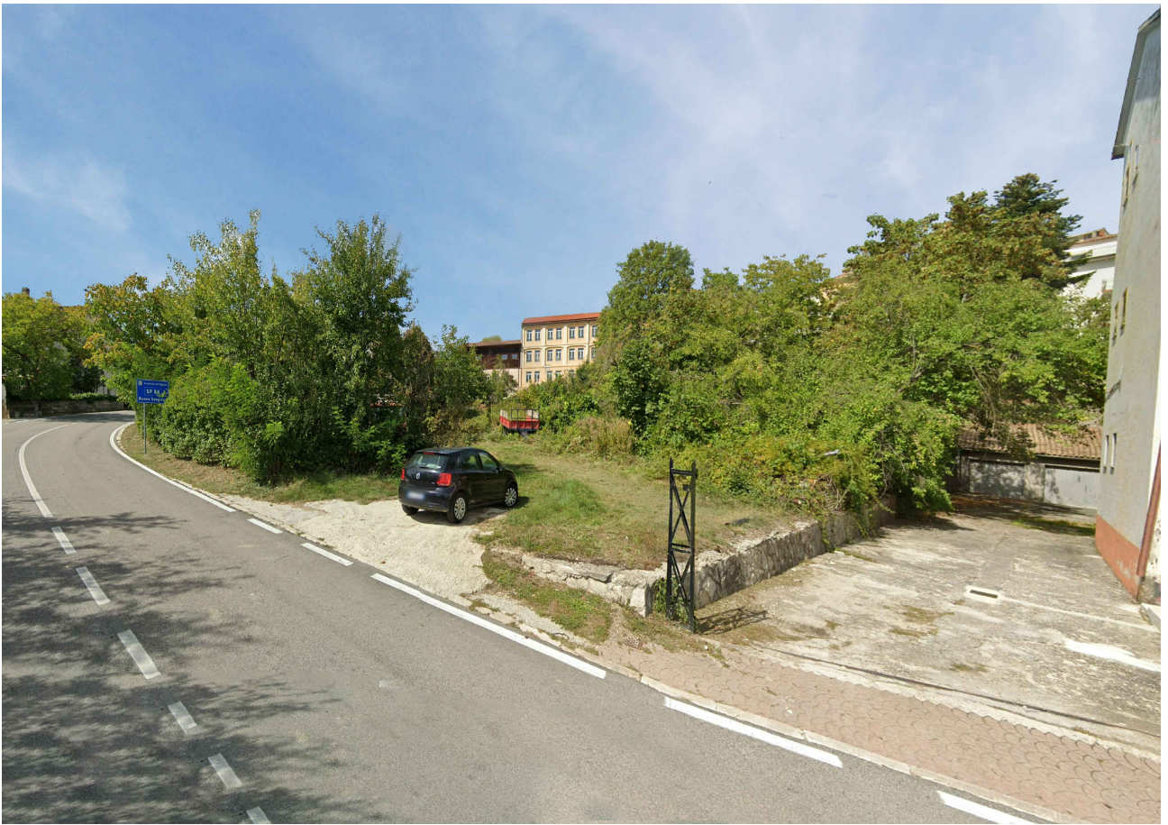
Fotografia - Stato di Fatto
