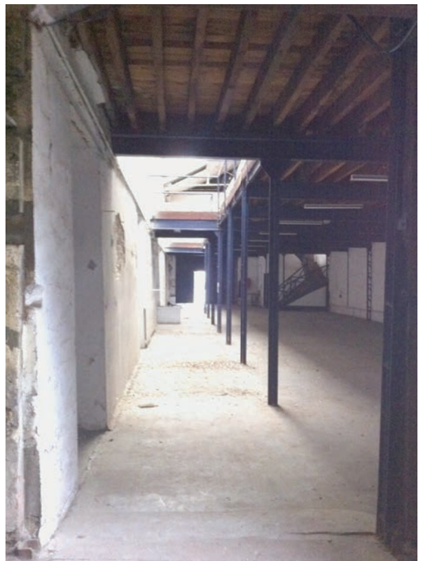
Identité Les architectes ont conservés entre autres le sol en béton, la structure métallique et l'empreinte de la grande verrière existante.
