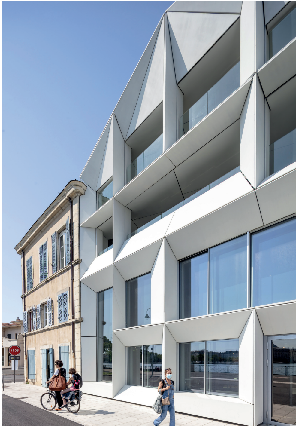
Vue sur l'entrée, côté extension — View of the entrance, extension side
