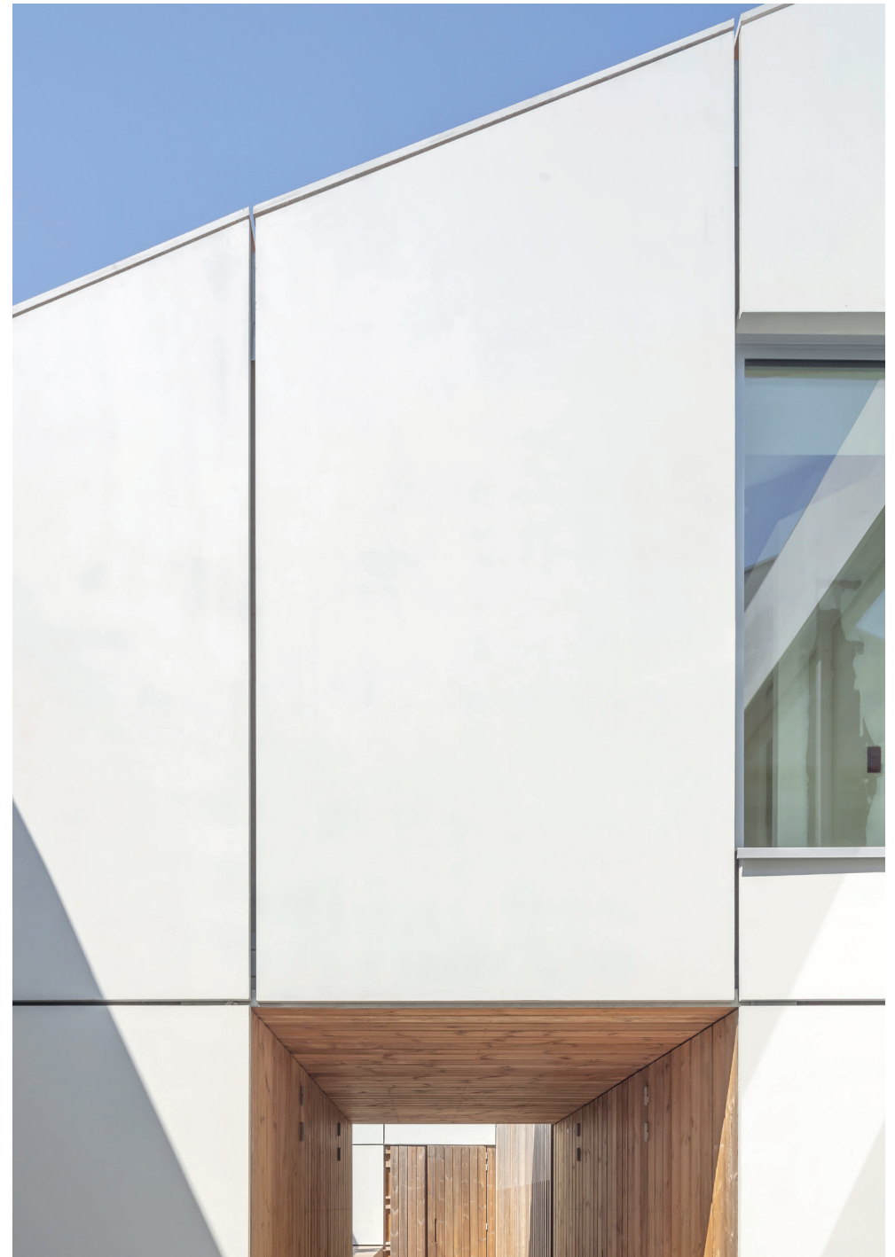
Détail sur les façades intérieures, niveaux logements — Close-up on interior facades, apartment levels
