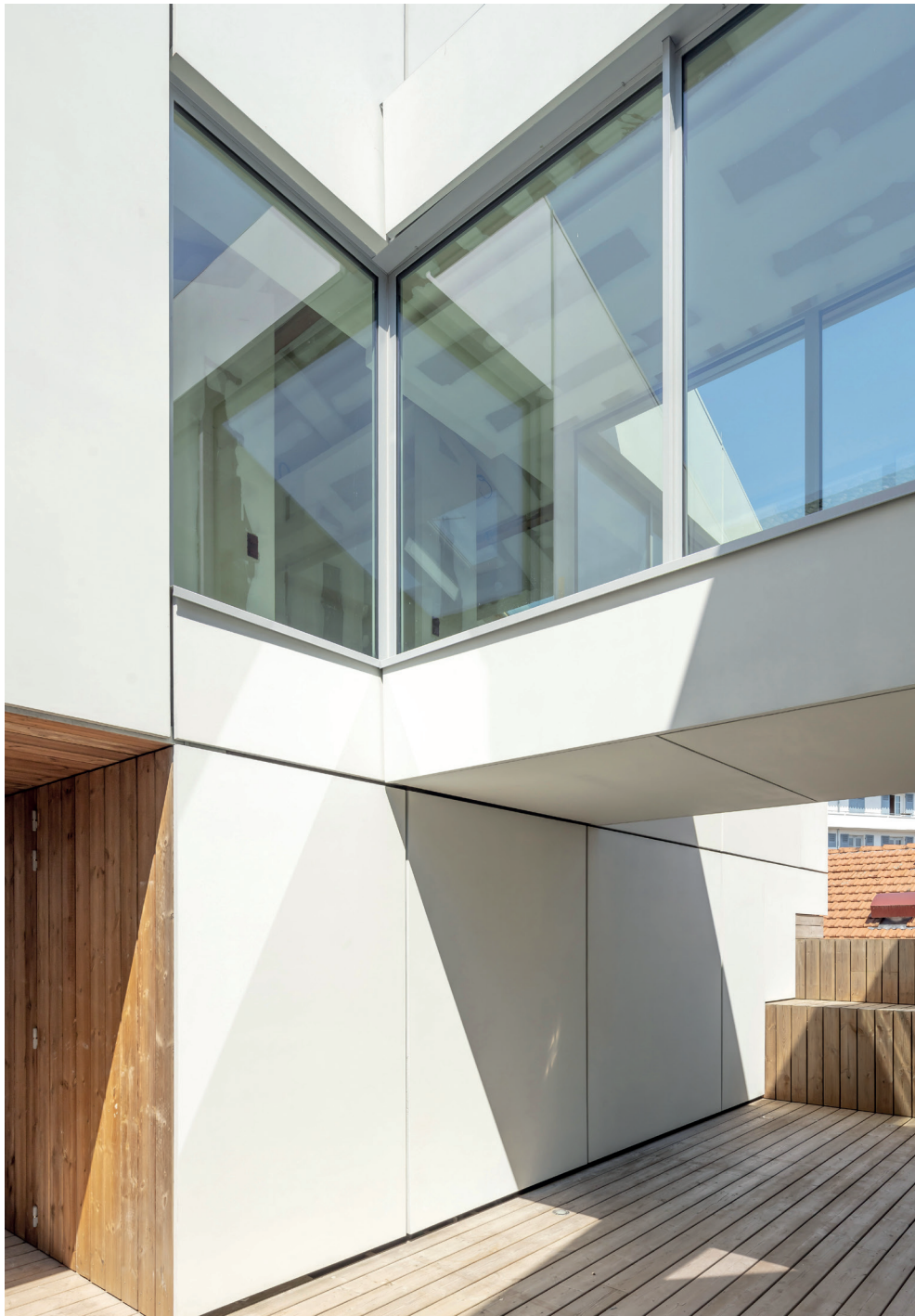
Passerelle, logement du troisième étage — Walkway, third-floor apartment
