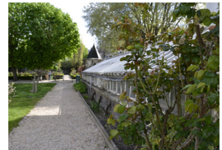
Extérieur de la serre avant intervention
