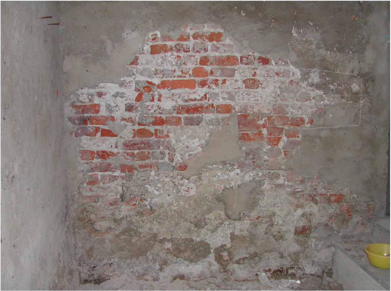
Foto n.19 Veduta della parete dopo la demolizione parziale dell'intonaco.
