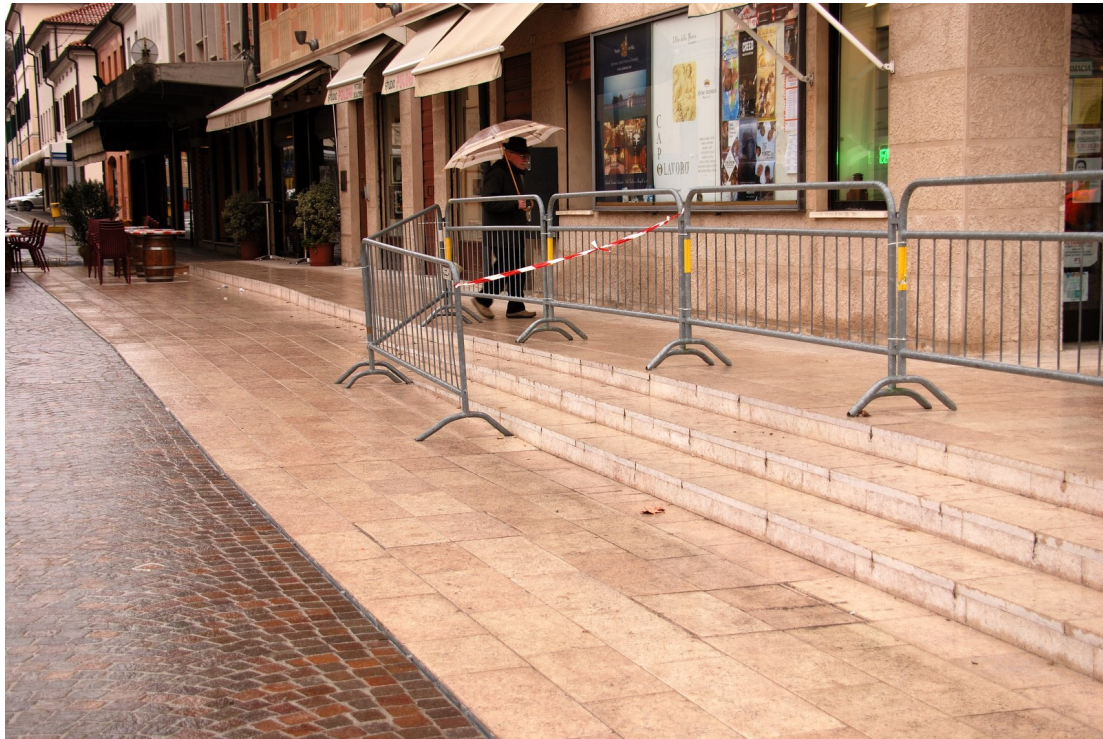
Il lato Ovest della nuova gradinata
