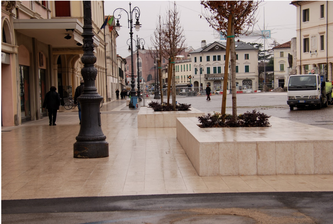
Gli ostacoli non segnalati e di restringimento del marciapiede sul lato Sud del Corso
