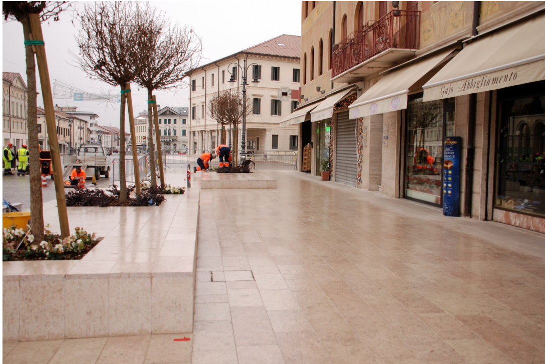
Gli ostacoli non segnalati e di restringimento del marciapiede sul lato Nord del Corso
