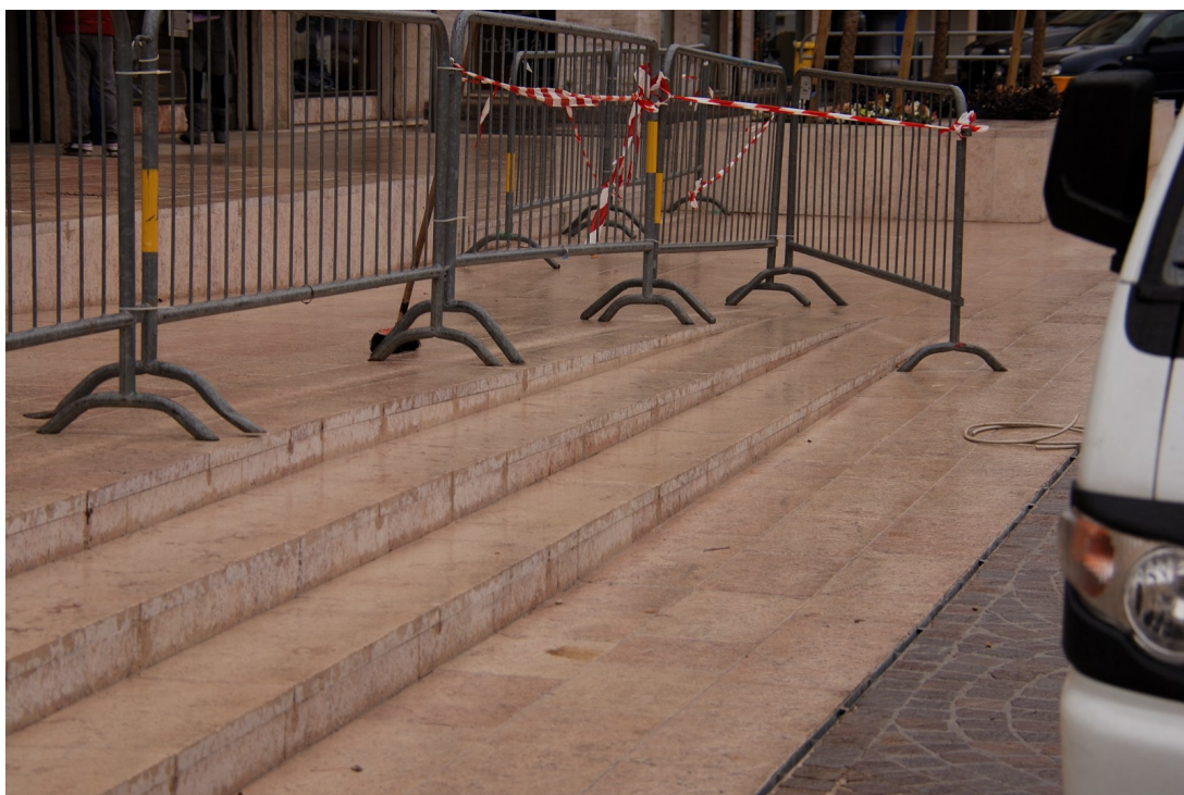
Il lato Sud della nuova gradinata
