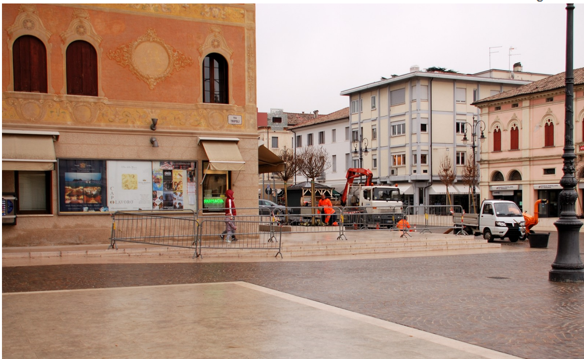
Il lato Ovest della nuova gradinata
