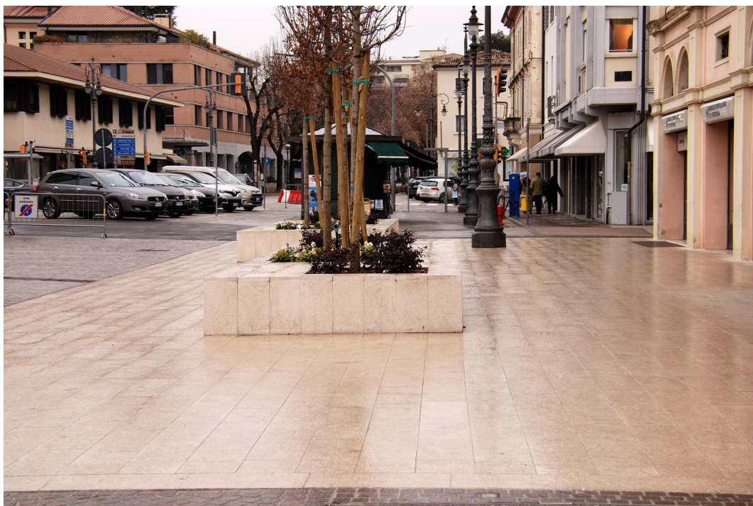
Gli ostacoli non segnalati lungo il marciapiede sul lato Sud del Corso
