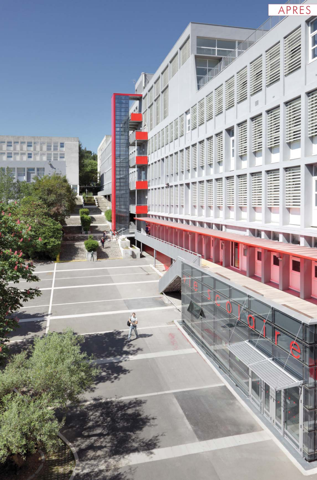
10. Le bâtiment B rénové avec sa façade Sud équipée de brise-soleil en aluminium laqué
