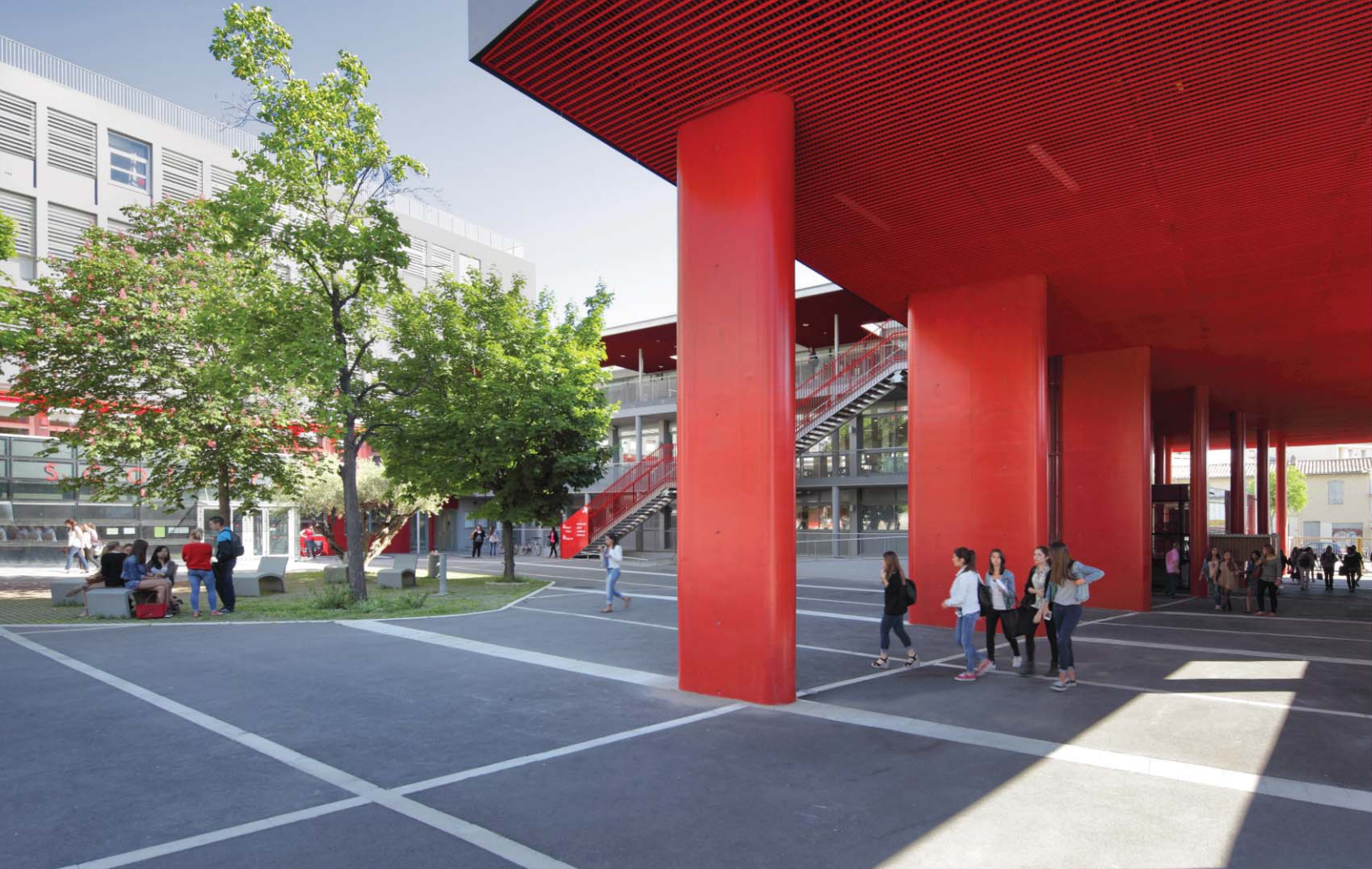
03. Le porche se transforme en préau
