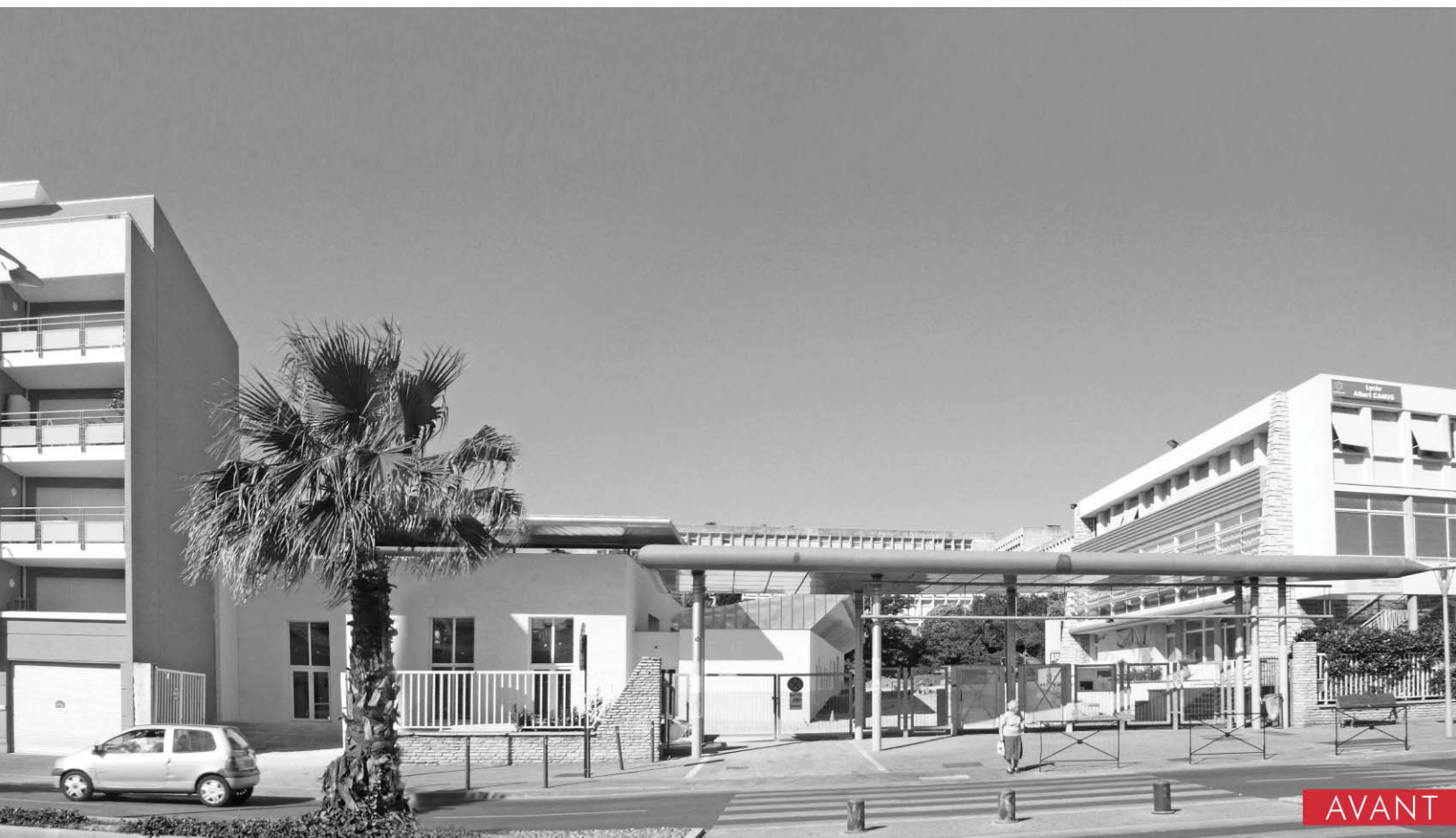
L'ancienne entrée avenue G.Pompidou
