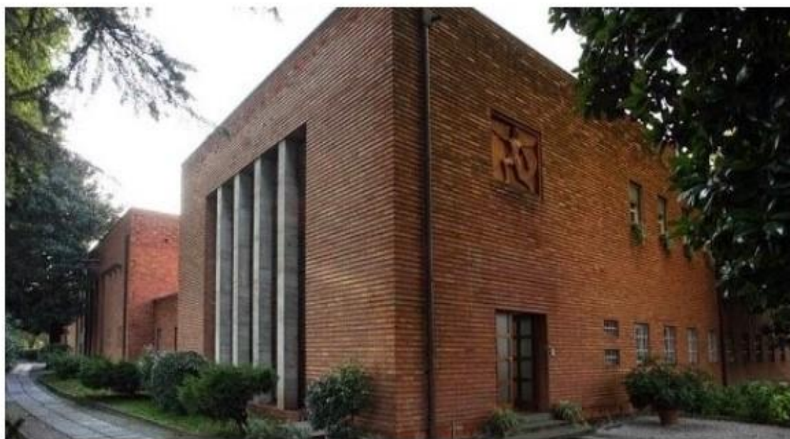
Gruppo Rionale Bonservizi, fabbricato Est, ingresso all'atrio dal lato Est.
