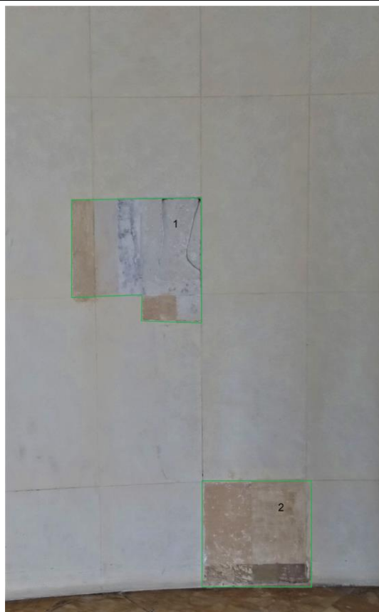
Saggi di pulitura 1 e 2 eseguiti sulla parete allo stato attuale.
