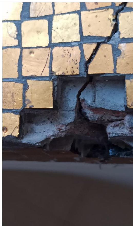
Dettagli delle zone di degrado: a sx visione dall'alto di una zona con mancanze di tessere di mosaico; a dx particolare profilo inferiore di una zona lacunosa con frattura e mancanze cospicue.
