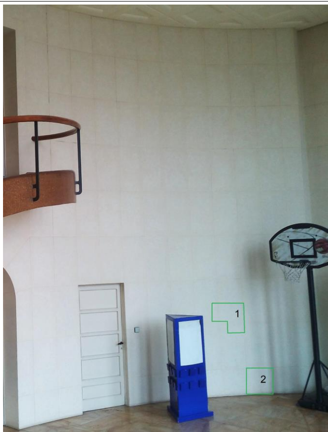
Atrio, interno, lato Nord-Est allo stato attuale prima dei saggi: mappatura dei saggi di pulitura 1 e 2.
