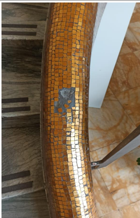
Dettagli delle zone di degrado: a sx visione dall'alto di una zona con mancanze di tessere di mosaico; a dx particolare profilo inferiore di una zona lacunosa con frattura e mancanze cospicue.
