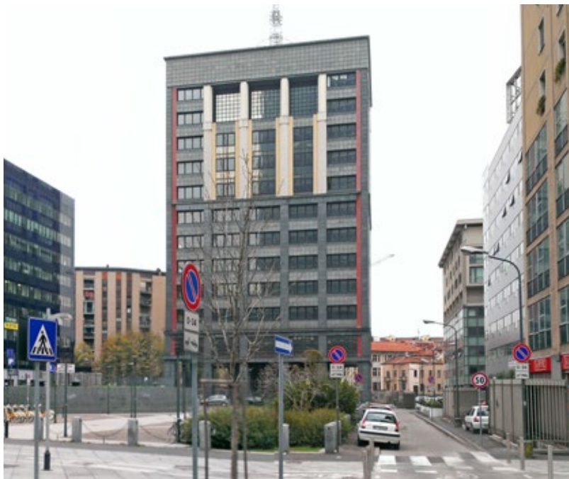
Prospetto da viale Restelli - Prima dell'intervento
