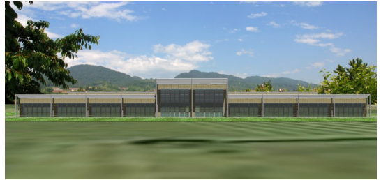
Fig. 2 - Le aule e la sala polivalente hanno le vetrate esposte a Sud completamente ombreggiate in estate dai frangisole fissi.
