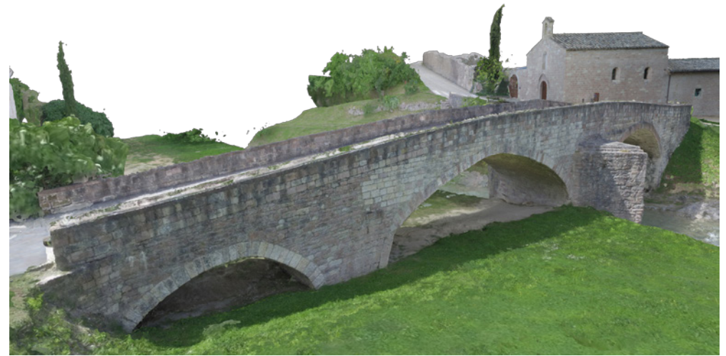
Fig. 3.3 - Rilievo fotogrammetrico in fasi: fase 3, creazione della texture fotorealistica (elaborazione di Raimondo Caruana).
