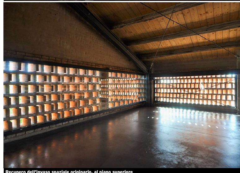
Recupero dell'invaso spaziale originario, al piano superiore
