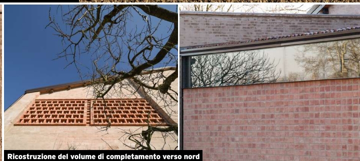
Ricostruzione del volume di completamento verso nord
