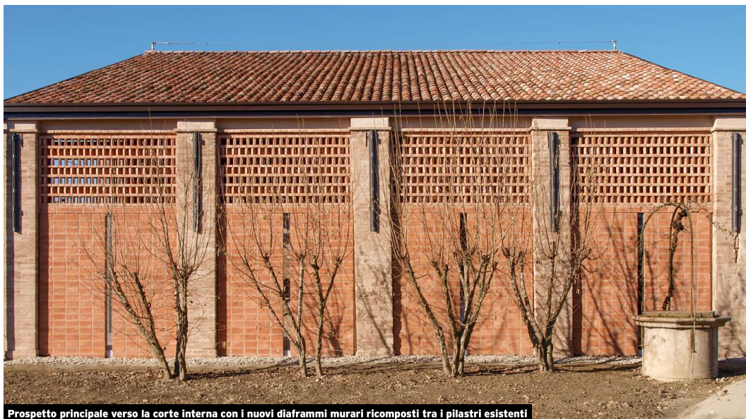
Prospetto principale verso la corte interna con i nuovi diaframmi murari ricomposti tra i pilastri esistenti
