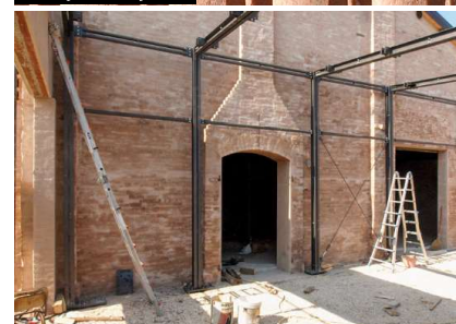
Piedritti del nuovo telaio metallico
