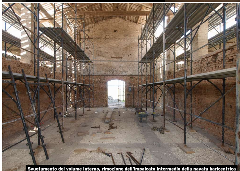
Svuotamento del volume interno, rimozione dell'impalcato intermedio della navata baricentrica
