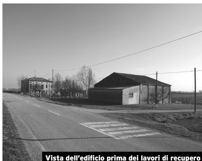
Vista dell'edificio prima dei lavori di recupero
