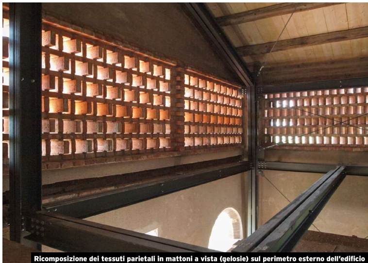
Ricomposizione dei tessuti parietali in mattoni a vista (gelosie) sul perimetro esterno dell'edificio
