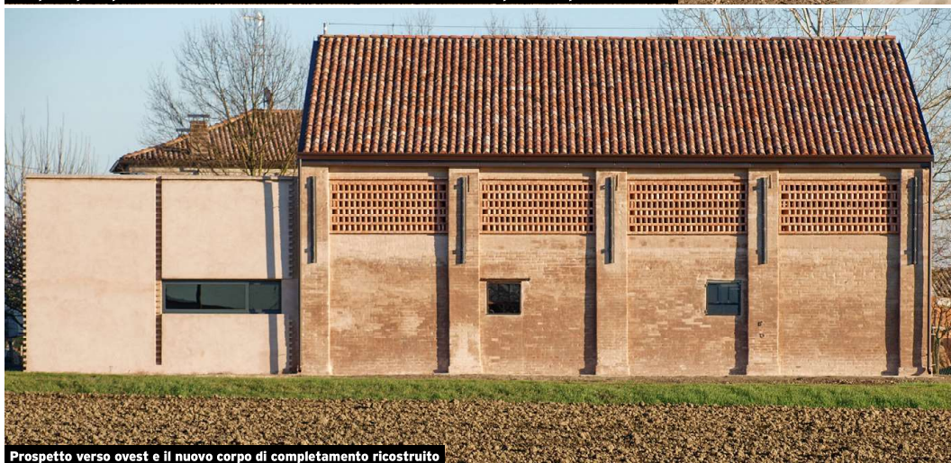
Prospetto verso ovest e il nuovo corpo di completamento ricostruito
