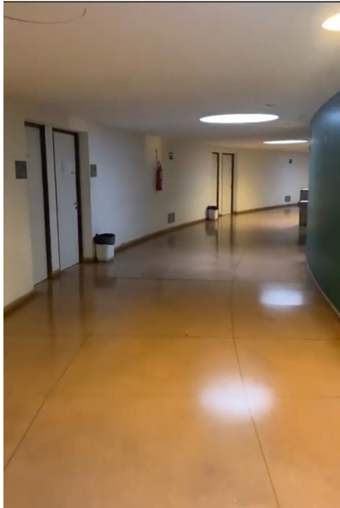
Figura 51: Aberturas zenitais do setor das salas de aula.
