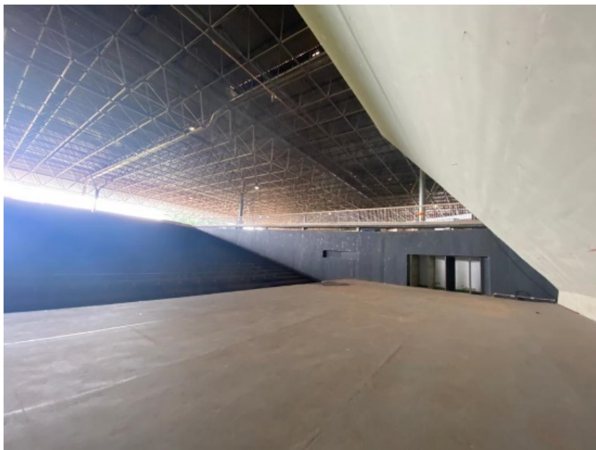
Figura 32: Rampa Acústica no Parque da Cidade atualmente.
