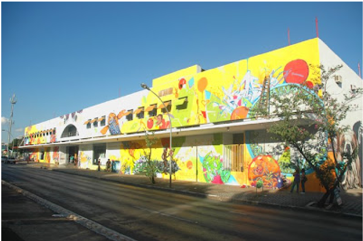
Figura 13: Espa o Cultural Renato Russo - Fachada principal.
