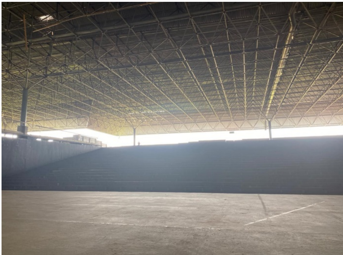
Figura 34: Rampa Acústica no Parque da Cidade atualmente.
