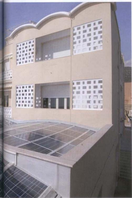
po fotovoltaico si presentava problematica per la differente inclinazione delle varie file di moduli; per questo motivo si è scelto di suddividere il sistema in 6 sottocampi.
