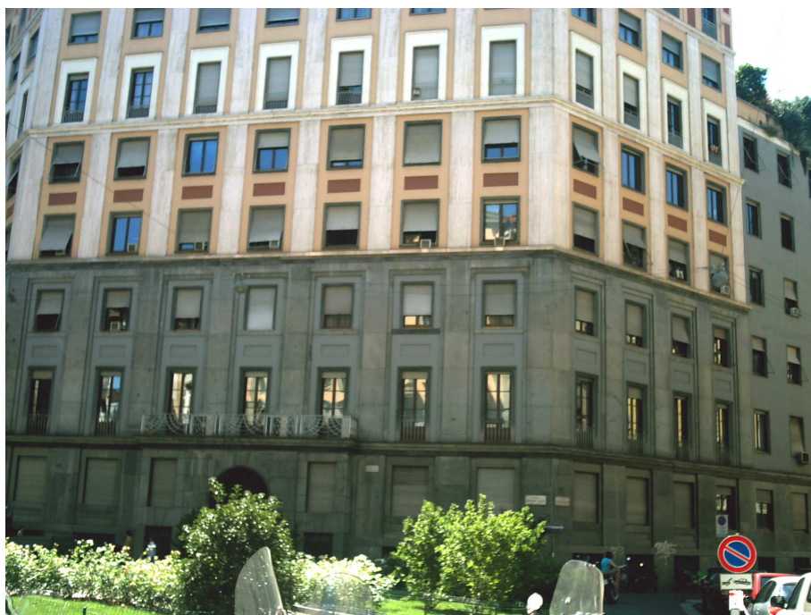
Altri dettagli delle facciate
