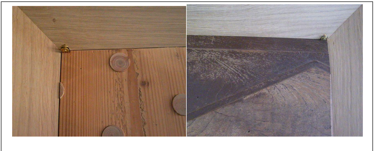
Abbiamo tenuto i “pollici” “passetti”, insomma le cerniere, il meno sporgenti possibili
